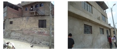
Viviendas con techo de losa aligerada y cubierta ligera en el último nivel
