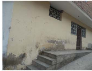
Viviendas con sobre cimiento de concreto ciclópeo
