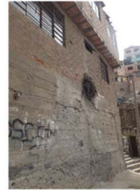
Vivienda cimentada sobre concreto ciclópeo
