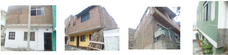
Edificaciones de dos pisos con techo de cobertura ligera
