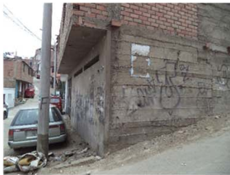
Viviendas con presencia de muros de concreto ciclópeo en el primer nivel
