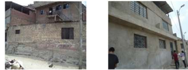
Viviendas con techo de losa aligerada y cubierta ligera en el último nivel
