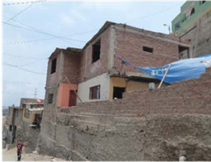
Viviendas con sobre cimiento de concreto ciclópeo
