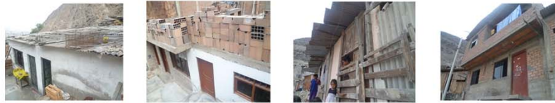
Edificaciones de un piso de techo aligerado y cobertura ligera
