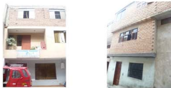
Edificaciones de tres pisos de techo aligerado y cobertura ligera
