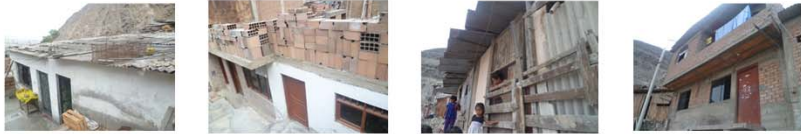
Edificaciones de un piso de techo aligerado y cobertura ligera
