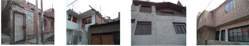
Viviendas con techo aligerado y cobertura ligera
