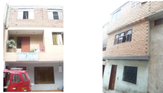
Edificaciones de tres pisos de techo aligerado y cobertura ligera
