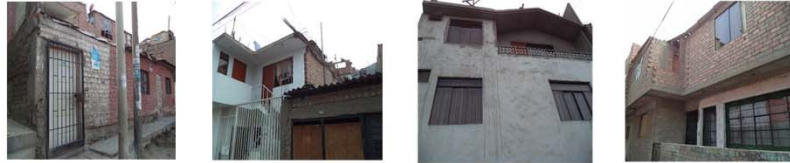
Viviendas con techo aligerado y cobertura ligera
