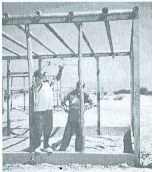
En lo posible, la madera debe ser de una sola pieza permitiendo unir una columna con otra. Si hubiese la necesidad de unir dos piezas de madera para formar la viga, se debe cuidar que los empalmes siempre estén apoyados sobre una columna o un parante.
