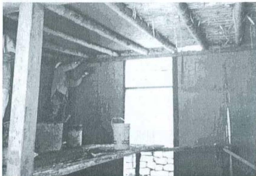
Esta cubierta se construye colocando las cañas en forma transversal a las viguetas de tal manera que se cubra todo el techo. Las cañas van clavadas a las viguetas y a su vez amarradas a clavos con alambre N° 16.
