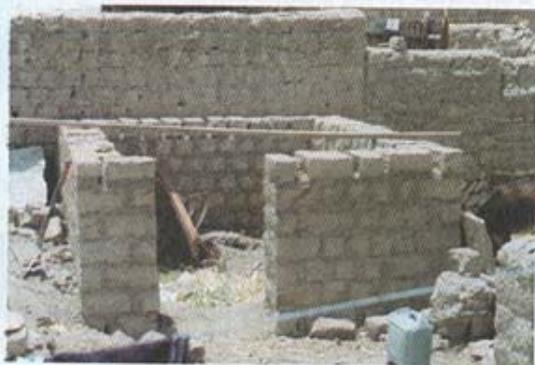
2. Limpieza y nivelación del piso del Chalero, para poder excavar los huecos para cimentación de columnas, con la misma profundidad y estas tengan la misma altura.
