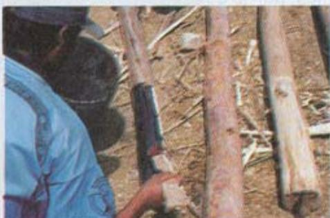
5. Cubrimos con brea el extremo del palo que se plantará en el suelo, porque es la parte que estará permanentemente en contacto con la humedad del terreno y el estar impermeabilizada evitará que se pudra con el tiempo.
