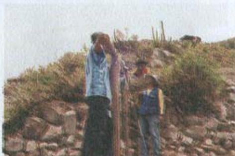
2. Marcar en las vigas, a la altura de las columnas, los puntos donde irán los clavos y ponerlas nuevamente en el suelo, para proceder a clavar con clavos de 5 Pulg. hasta que la punta aparezca por el otro lado del palo (Utilizar alguna materia grasa, puede ser cebo, para que los clavos penetren con mayor facilidad).
