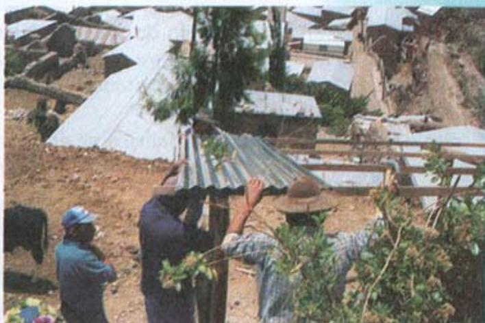
2. El filo lateral o borde de la calamina debe quedar señalando hacia abajo y solo debe montarse o traslaparse un canal entre plancha y plancha.
