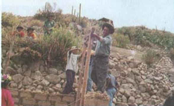
Luego subirlas nuevamente sobre las columnas y sujetando firmemente, continuar clavando hasta introducir totalmente los clavos. Una vez fijos los cuatro puntos, clavar un clavo más en cada punto.
