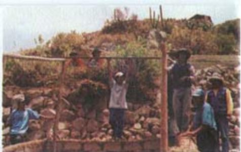
Efectuamos el mismo proceso de clavado de las vigas (Leer el numeral 2), solo que esta vez utilizamos clavos de 4 Pulg. Amarrando finalmente con alambre galvanizado en cada cruce de las correas con las vigas
