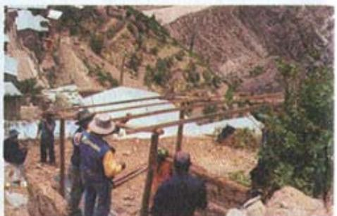
7. Los extremos más gruesos de las correas deben colocarse hacia el mismo lado y alinearse con el extremo de la primera correa instalada. De ser necesario utilizar un cordel.
