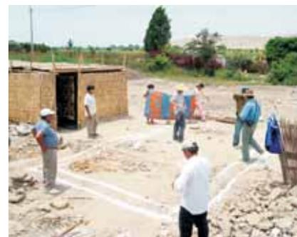
**Corte y relleno:** Si el terreno está en pendiente podemos nivelarlo cortando el sector más elevado y rellenando el sector más bajo con la tierra obtenida del corte del sector alto, formando una plataforma. Pero siempre la cimentación de la casa debe estar asentada sobre el suelo firme y no sobre el relleno de la plataforma (ver FIG. 1). El relleno se hace por capas de 20 cm. debidamente compactadas cada una de ellas, antes de construir sobre la plataforma final.
