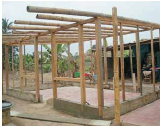
**Travesaños:** Son maderas que colocan transversales a los parantes. Deben colocarse por lo menos tres filas de travesaños dispuestos de la siguiente manera: Debajo de la viga solera, a media altura de la pared y encima del sobrecimiento.
