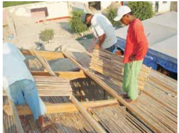
**Techo con viguetas:** Es el techo más común y económico. Las viguetas son las maderas aserradas o caña guayaquil de 4" de diámetro que están clavadas sobre las vigas soleras en forma espaciada.
