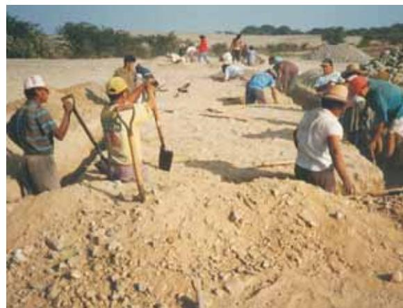
**b) Si el suelo es arenoso o poco consistente, la cimentación debe ser reforzada con armadura de hierro (concreto armado)**
