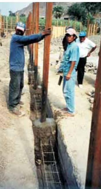
**a)** Parantes de madera tornillo de 3" x 4" colocados a ambos lados de puerta y ventanas, conforman junto con los dinteles y alfeizares los vanos de la vivienda.
