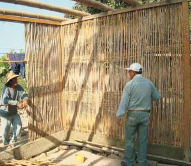
**Cerramiento de paredes:** Para cerrar las paredes se colocan cañas, una al lado de otra, en forma vertical, trenzadas sobre los travesaños. No se requiere clavos. Por lo menos dos días antes se cura la caña bañándola en petróleo, protegiéndola así de los insectos.
