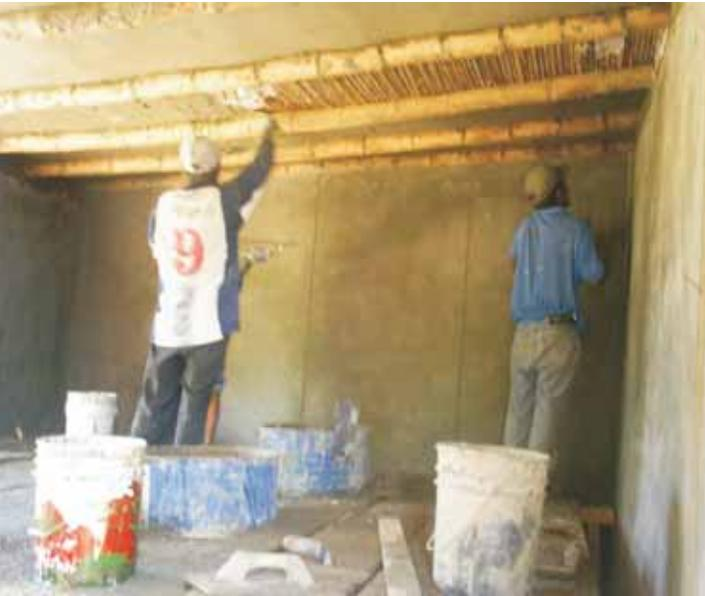
**Cubierta con caña y barro:** La ventaja de este tipo de cubierta es que aísla el ambiente interior de la casa del clima exterior, a diferencia de las calaminas que transmiten el clima exterior.
