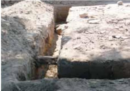
**Ancho de la Zanja:** La zanja para los cimientos de una vivienda de quincha mejorada construida sobre suelo compacto, debe tener 40 cm. de ancho. En suelos poco consistentes podría ser mas ancho.
