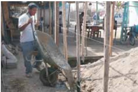
**Cimiento:** Antes del vaciado del cimiento debe verificarse que estén colocadas todas las tuberías de agua y desagüe que van a cruzar los cimientos o en todo caso, cuidar de dejar pases para colocar posteriormente las tuberías.
