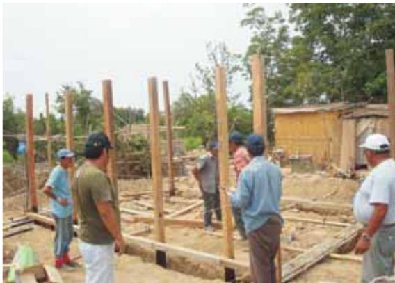
En la parte de la madera que va a quedar empotrada en el cimiento se colocan clavos de 4 pulgadas, 6 por cada lado, formando una especie de mechón. Esto ayudará a anclar la columna en el cimiento. La columna plantada debe quedar rodeada con mezcla por debajo y por los 4 costados.
