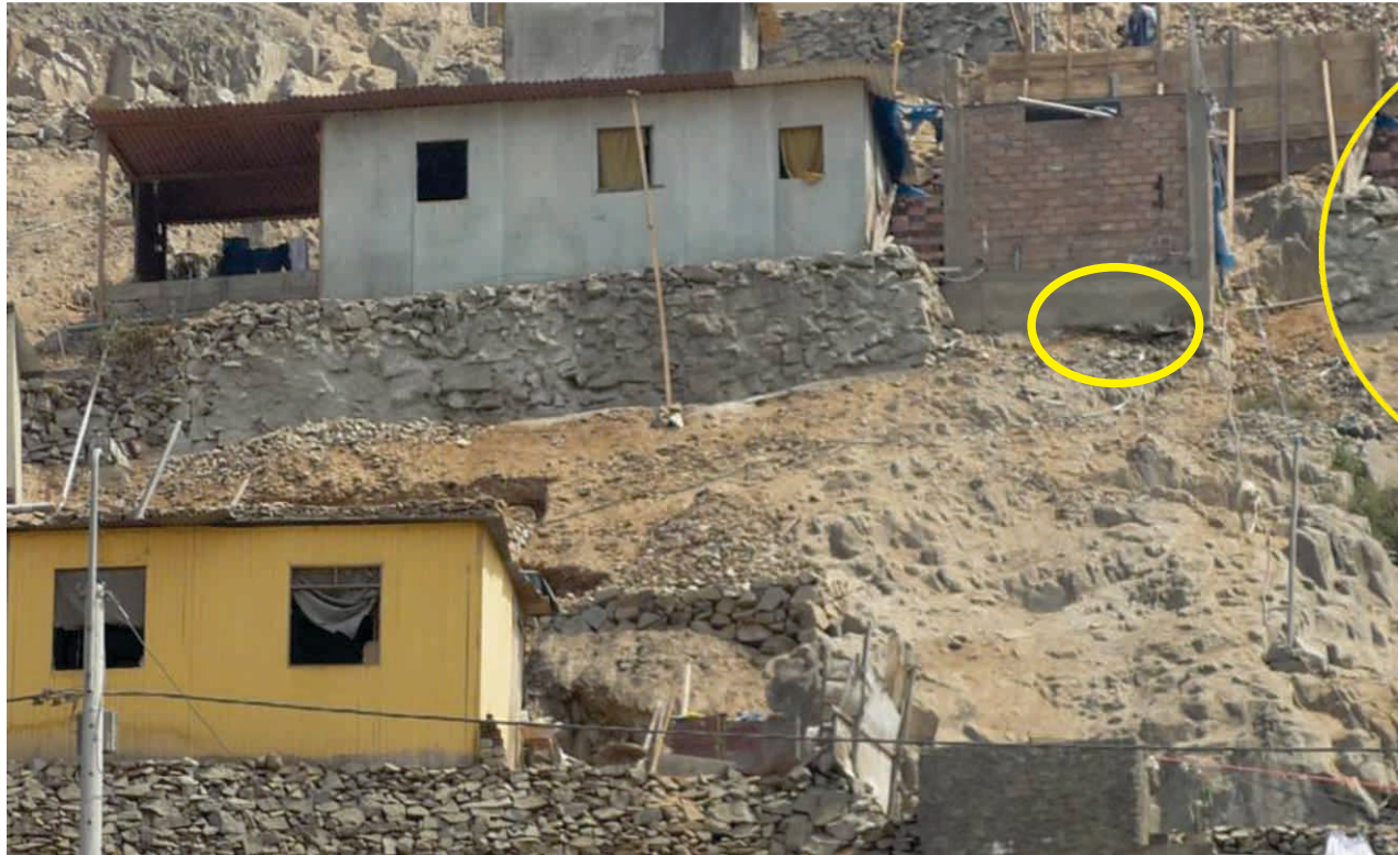
Viviendas precarias ubicadas en ladera. Puede observarse la inclinación de la habitación en ladrillo y concreto, por pérdida de apoyo
