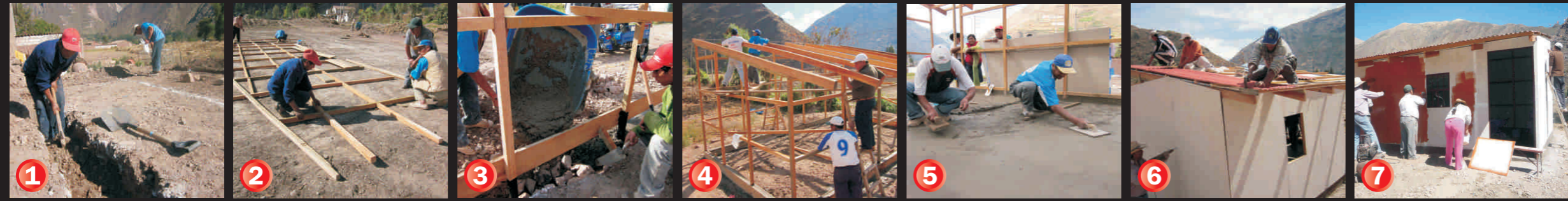
1 Trazado del terreno y zanjado
