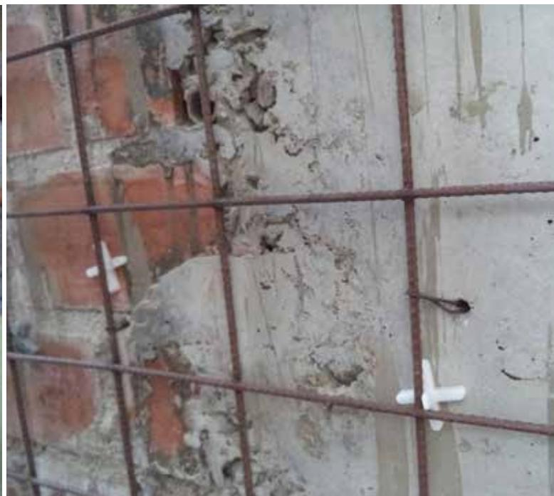
*Atortolamiento de la malla fijada al muro y confinamiento*
