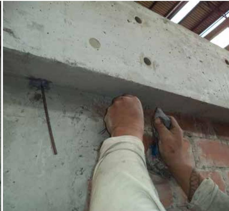
*Fijación de barra de transferencia en viga y cimiento con epóxico*
