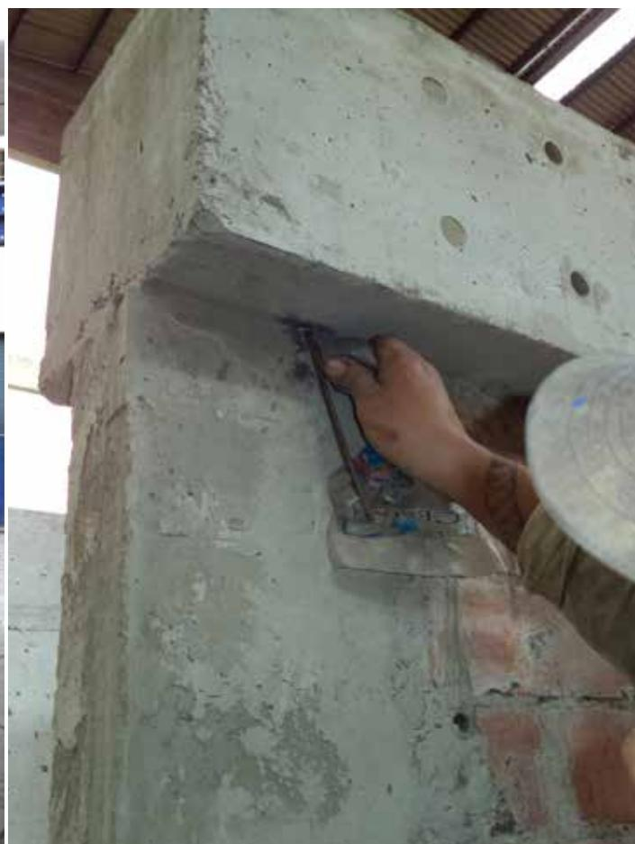
Perforaciones en muro, cimiento y viga para pasar alambre No.16
