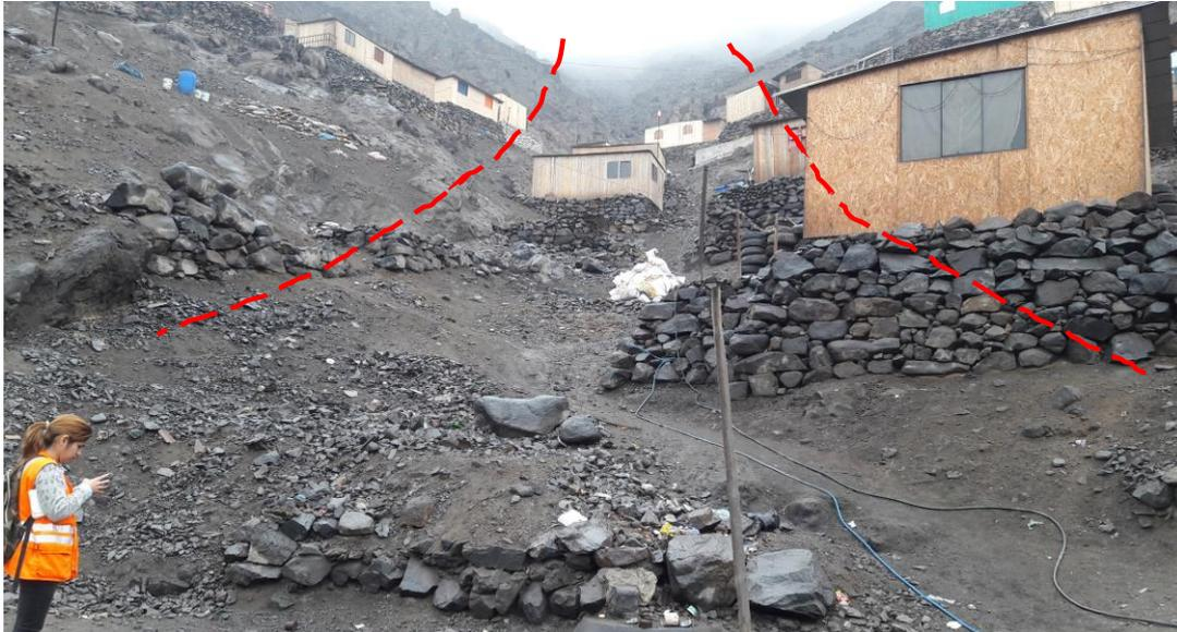
**Figura 03.** Viviendas asentadas en pleno cauce de una quebrada, que se encuentran expuesta a inundaciones o flujos de escombros.
