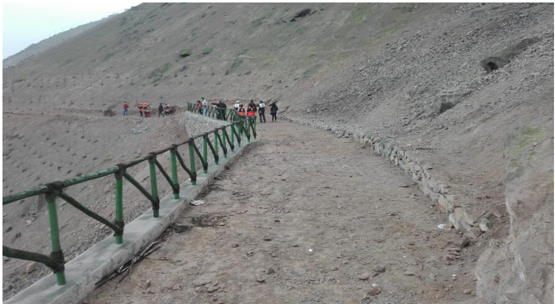
Parte posterior del muro de retención – terraza
