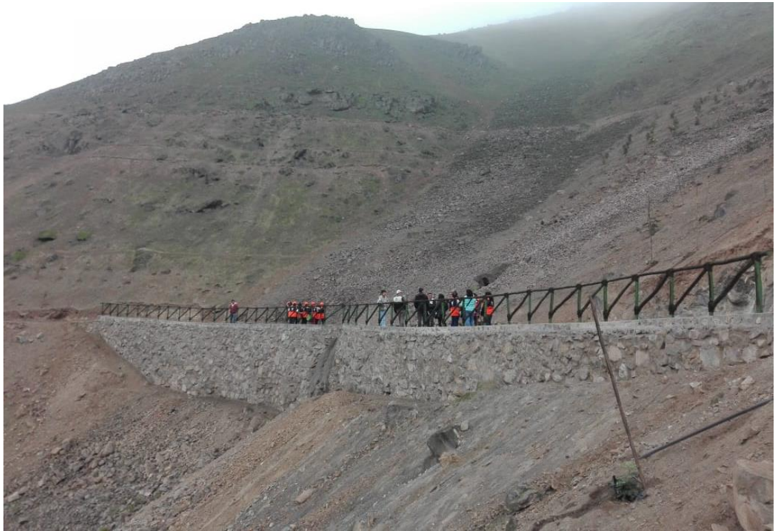
Muro de retención terminado
