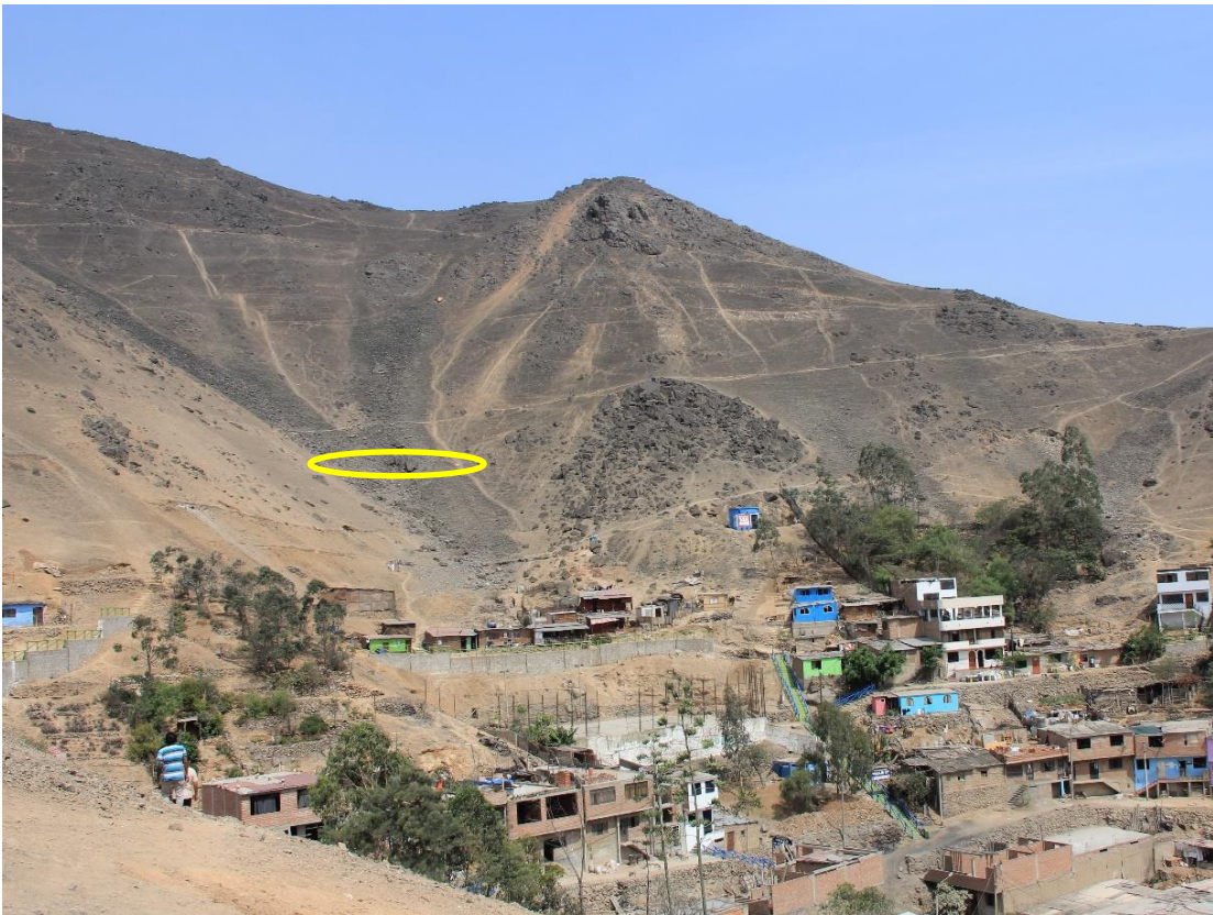
Ubicación del muro de retención
