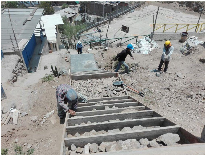
Proceso constructivo de escalera de acceso a zona de forestación
