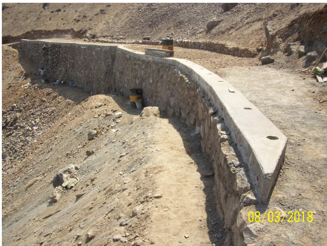
Muro de retención en proceso de construcción
