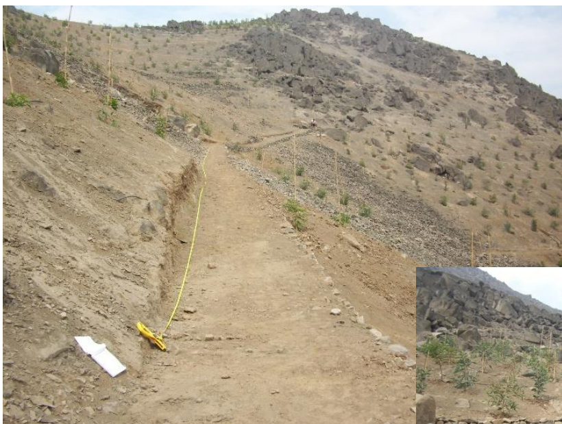
Vista del camino de herradura finalizado
