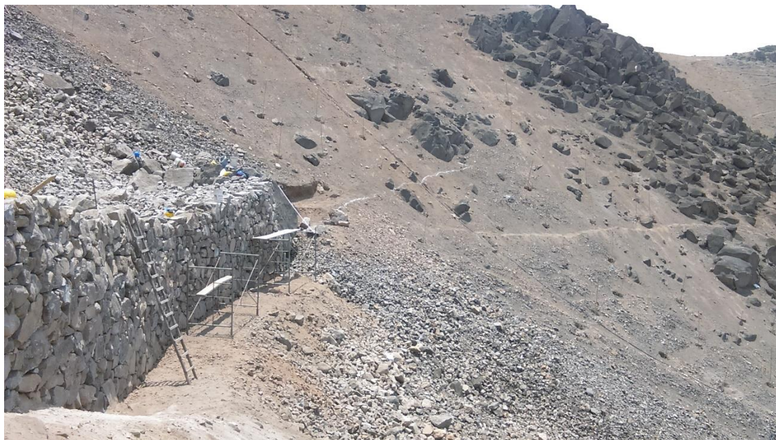
Muro de retención en proceso de construcción
