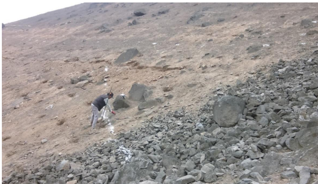
Trazado del muro de retención, lado izquierdo del afloramiento rocoso
