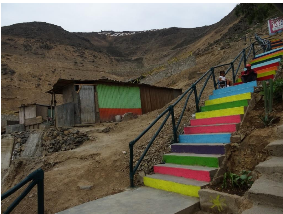
Escalera de acceso culminada
