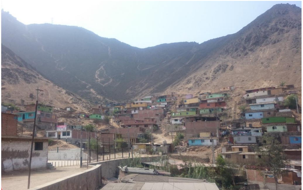
Fotografía N° 2-04 Zonas en Riesgo
