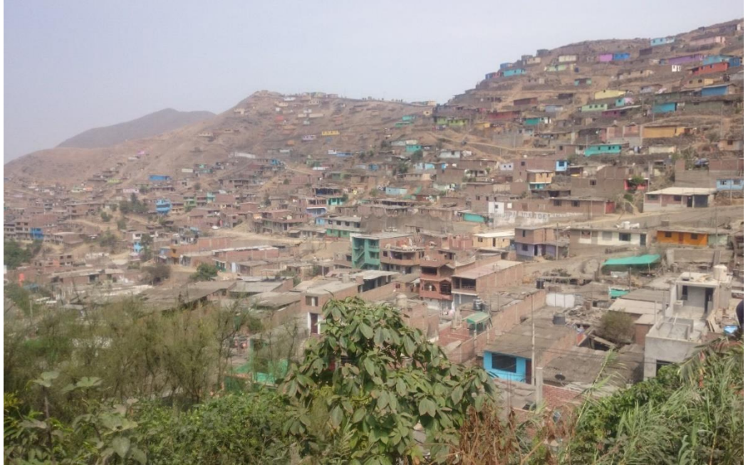
Fotografía N° 2-03 Zonas en Riesgo
