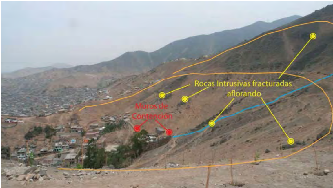
Figura 2. En la fotografía se muestran las relaciones que existen entre pendientes fuertes de la zona alta y los sitios donde afloran las rocas intrusivas fracturadas. Además se muestran los sitios donde se ubican los muros de contención de cemento y roca. La línea azul muestra por donde podría bajar el agua en caso de precipitaciones
