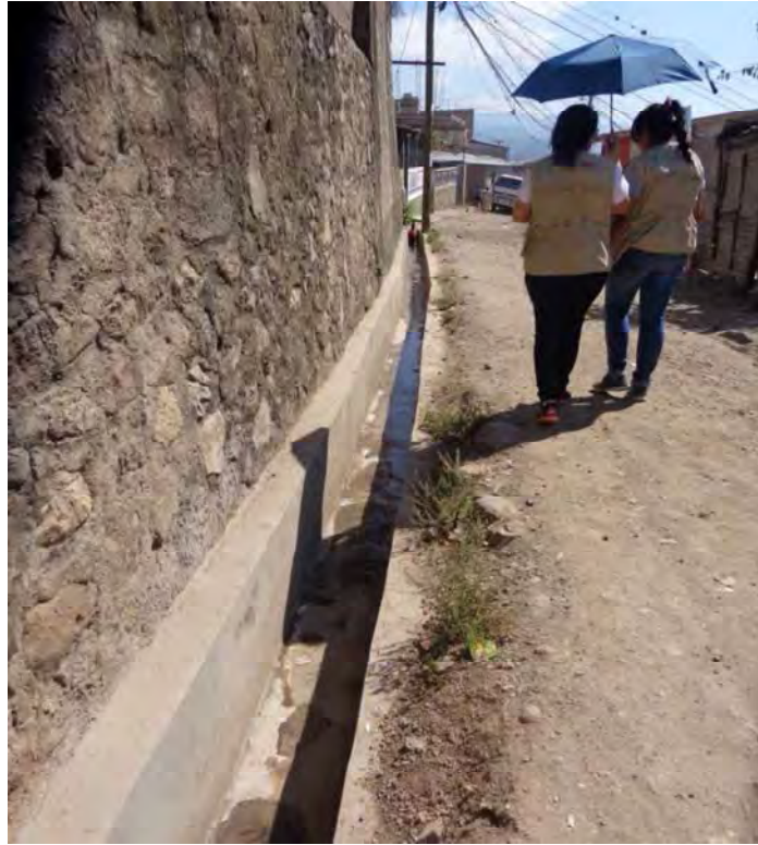
Figura 3. En la fotografía se muestra una de las cunetas que se han construido para mejorar el manejo de aguas superficiales. Con esto se ha mejorado la preservación de las calzadas y disminución de infiltración.
