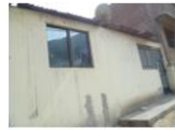
Edificaciones de un piso de techo aligerado y cobertura ligera
