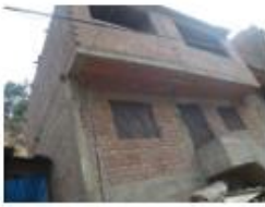
Edificaciones de dos pisos con techo de cobertura ligera
