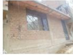
Edificaciones de un piso de techo aligerado y cobertura ligera
