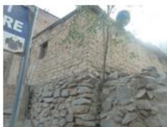
Vivienda con cimentación hecho a base de piedras
