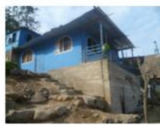
Vista de muro de contención
