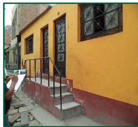
Viviendas con un sobrecimiento y acceso elevado a su primer nivel
