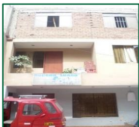
Edificaciones de tres pisos de techo aligerado y cobertura ligera
