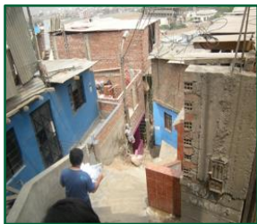
Viviendas con un sobrecimiento y acceso elevado a su primer nivel
