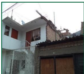
Viviendas con techo aligerado y cobertura ligera
