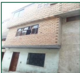
Edificaciones de tres pisos de techo aligerado y cobertura ligera
