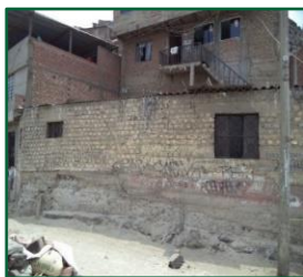
Viviendas con techo de losa aligerada y cubierta ligera en el último nivel
