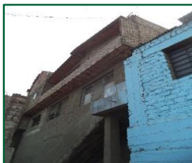
Viviendas con presencia de muros de concreto ciclópeo en el primer nivel
