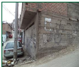
Viviendas con presencia de muros de concreto ciclópeo en el primer nivel
