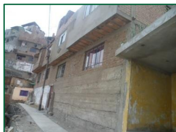
Muro de concreto en primer nivel
