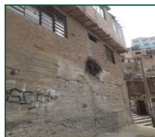
Vivienda cimentada sobre concreto ciclópeo
