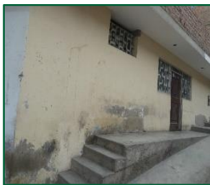
Viviendas con sobrecimiento de concreto ciclópeo
