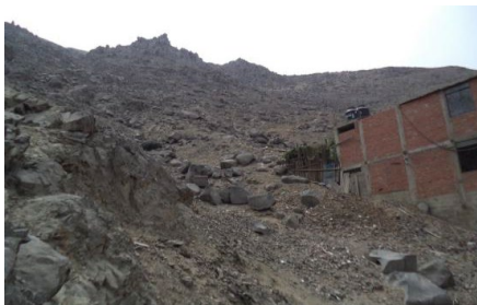
Laderas de fuerte pendiente con bloques de rocas sueltas
