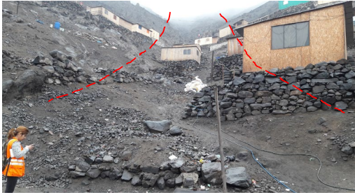
Viviendas asentadas en pleno cauce de una quebrada, que se encuentran expuestas a flujos de agua y escombros
