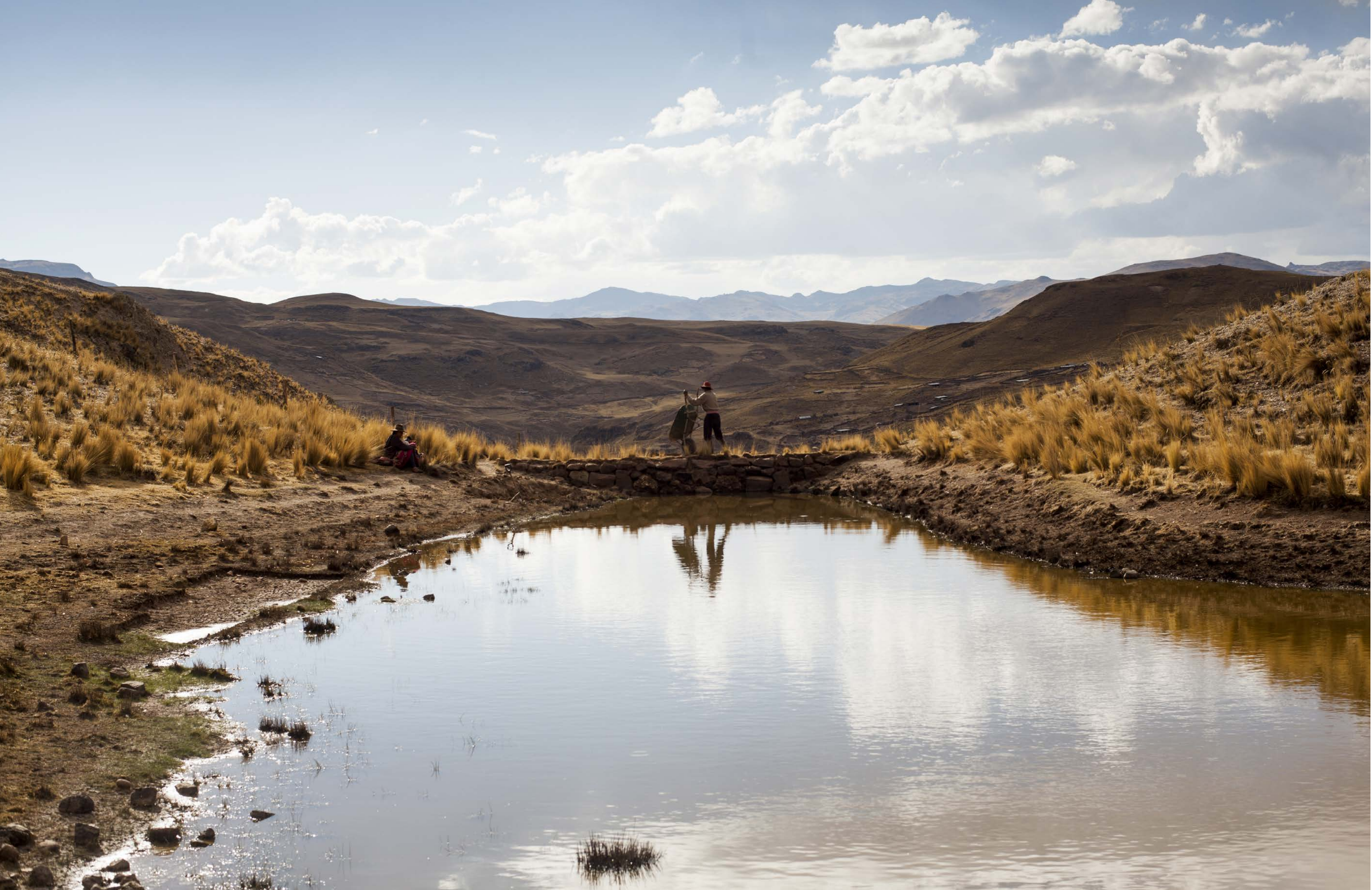
➔ Mantenimiento necesario. Los comuneros Brígida Consone y Clemente Choquipuma trabajan en el refuerzo del dique de la qochra de Quillhuara. Los efectos positivos de esta laguna se observan tierras abajo en la recuperación de manantes y ojos de agua.
