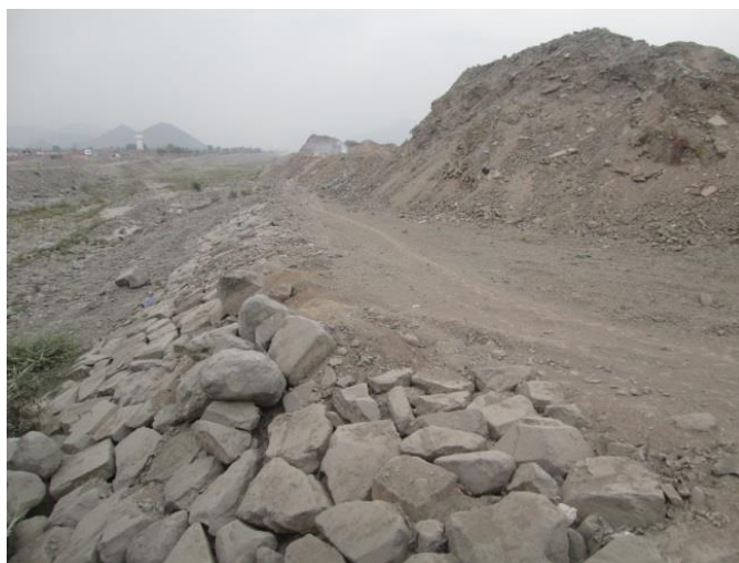
Fuente propia: Acumulación de desmontes en los márgenes del río Chillón, altura del Puente San Martín, distrito de Carabaylo.
