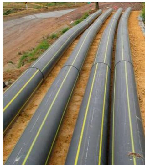
Figura 76. Instalación de Tuberías de Polietileno Acueducto - Acuaflex
