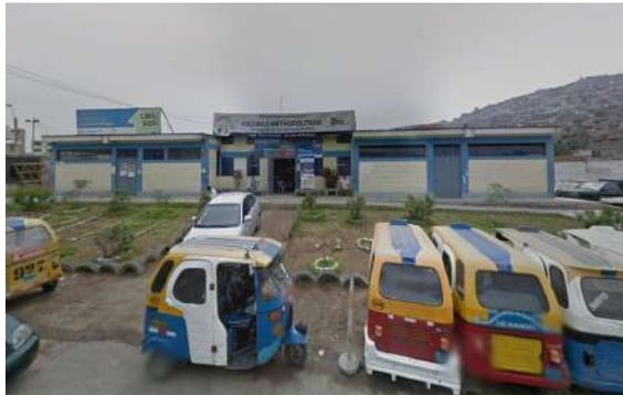
**Escuela Metropolitana de Formación de Emprendedores**. Edificación con sistema constructivo mixto: aporticado y albañilería confinada cuenta con un piso, se puede apreciar el problema de columnas cortas en la edificación.
