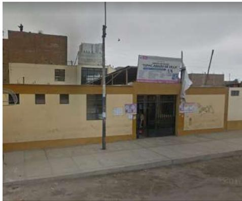
**Centro de Salud Túpac Amaru de Villa**, Edificación de concreto armado con Sistema constructivo mixto, aporticado y de albañilería confinada, cuenta con dos pisos.
