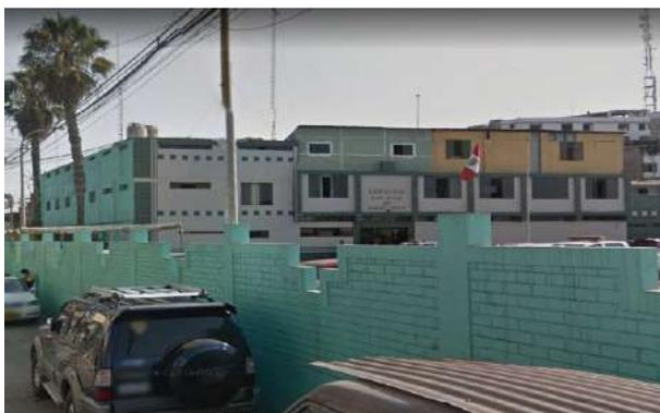
**Comisaria San Juan de Miraflores.** Edificación con sistema constructivo mixto: aporticado y albañilería confinada, con un muro perimétrico confinado.
