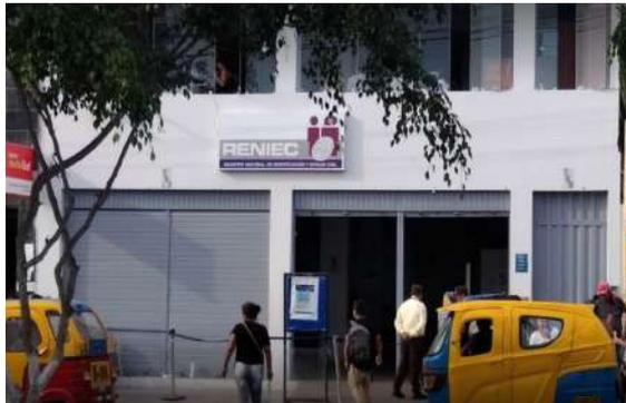
**Local del Registro Nacional de Identificación y Estado Civil (RENIEC)**. Edificación con sistema constructivo de albañilería confinada, cuenta con 2 pisos.
