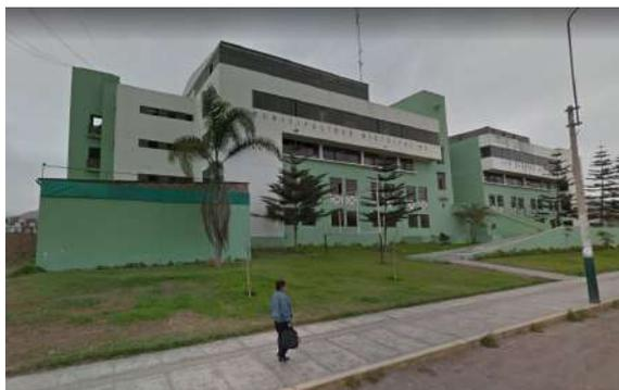
**Local Municipalidad de San Juan de Miraflores**, Edificación de concreto armado con Sistema constructivo de tipo aporticado, aparentemente en regular estado de conservación
