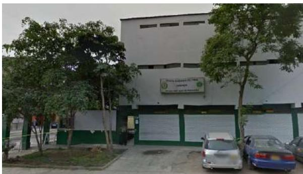
**DIVINCRI** San Juan de Miraflores, Edificación con sistema constructivo mixto: aporticado y albañilería confinada, tiene tres pisos, el último piso tiene techo de eternit.
