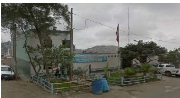
**Comisaria Pamplona alta II,** Edificación con sistema constructivo de albañilería confinada, cuenta con 2 ambientes, tiene dos pisos con techo de concreto armado y un ambiente de un piso con techo tipo pandereta.
