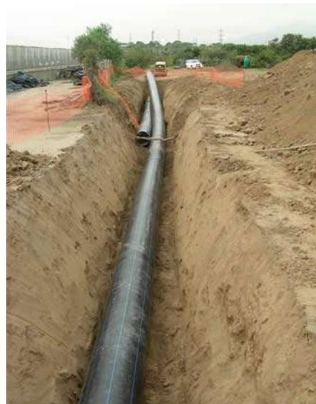
**Figura 78. Instalación de Tuberías de Polietileno Acueducto - Acuaflex**
