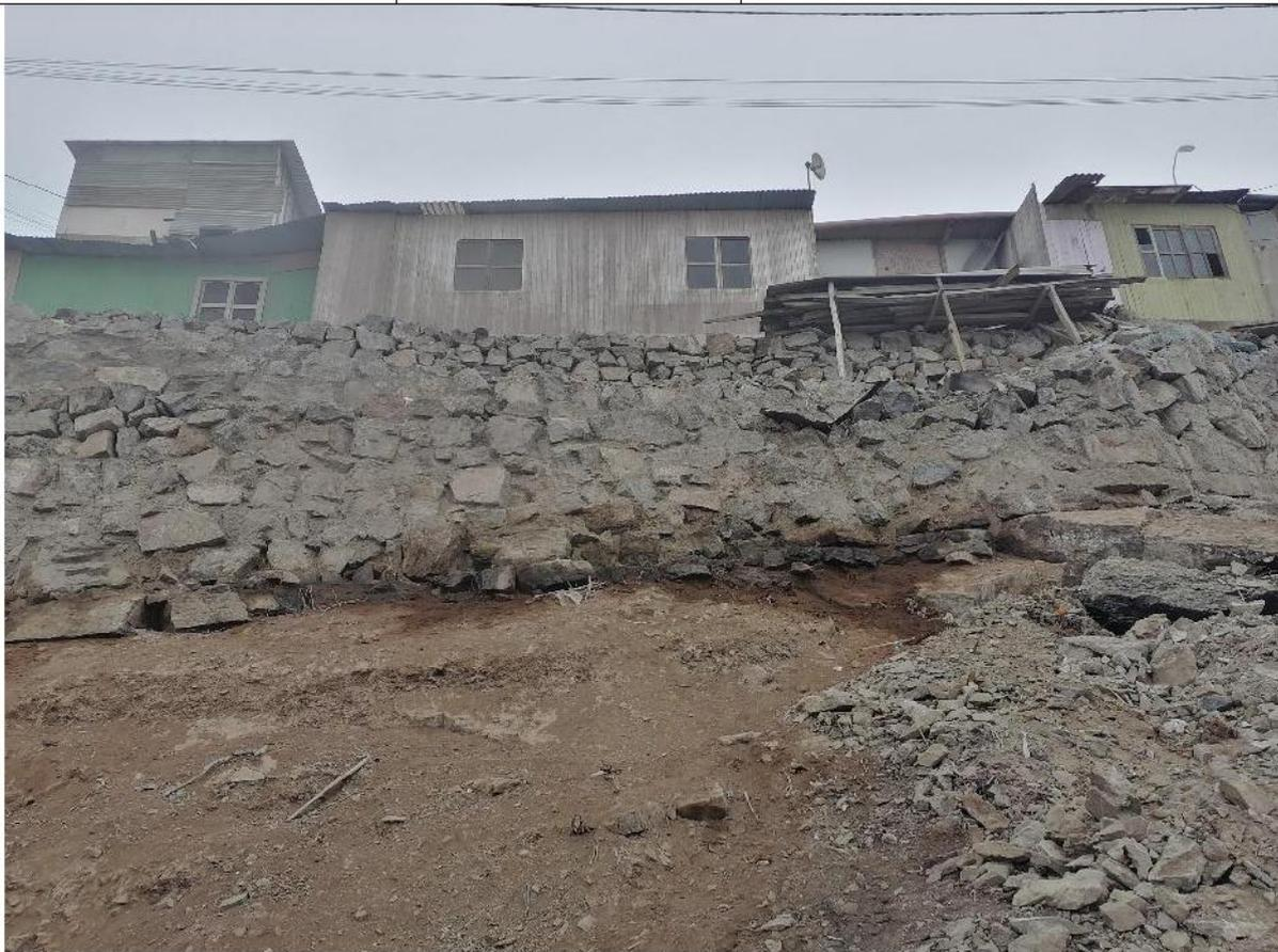
**Foto 03- Descripción situacional:** Vista de las viviendas asentadas sobre pircas poco consistentes, las cuales las han colocado sobre el material de afloramiento rocoso, que no garantiza su estabilidad, deslizando ante cualquier movimiento sísmico de gran magnitud y afectar a las viviendas ubicadas en la parte inferior.
