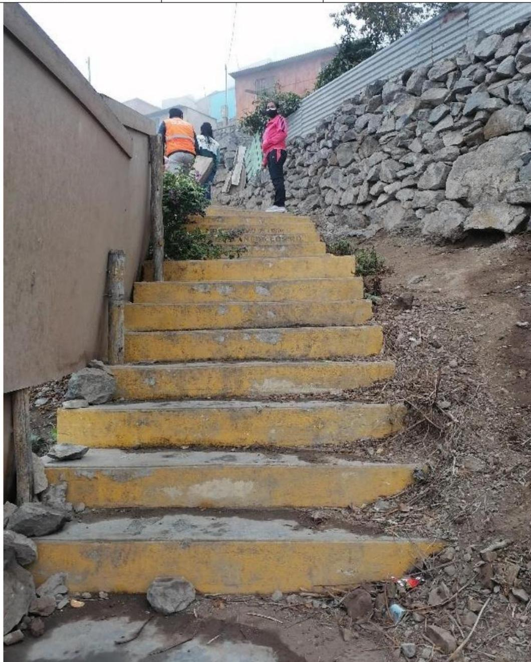
**Foto 02- Descripción situacional:** En la imagen se aprecia, al igual que en otras vías de comunicación (escaleras), no tienen una adecuada seguridad para dado la ubicación de rocas apiladas en los bordes, no cuentan con algún tipo de material que les de sostenibilidad y las escaleras están sin barandas. En algunos puntos han colocado pircas para la construcción de sus viviendas, incluso sobre el propio material rocoso.
