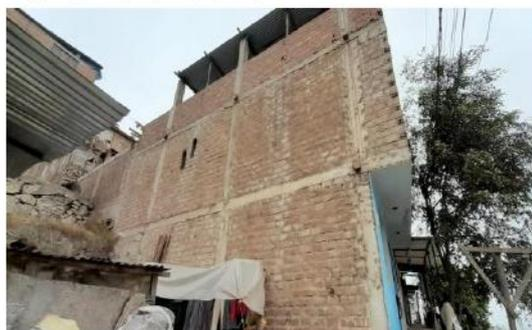
**Descripción:** Vivienda de 2 pisos de albañilería confinada, con muros frágiles (ladrillos delgados y con huecos), y una estructura muy esbelta de columnas. Las esquinas de los muros del voladizo no están confinadas.
