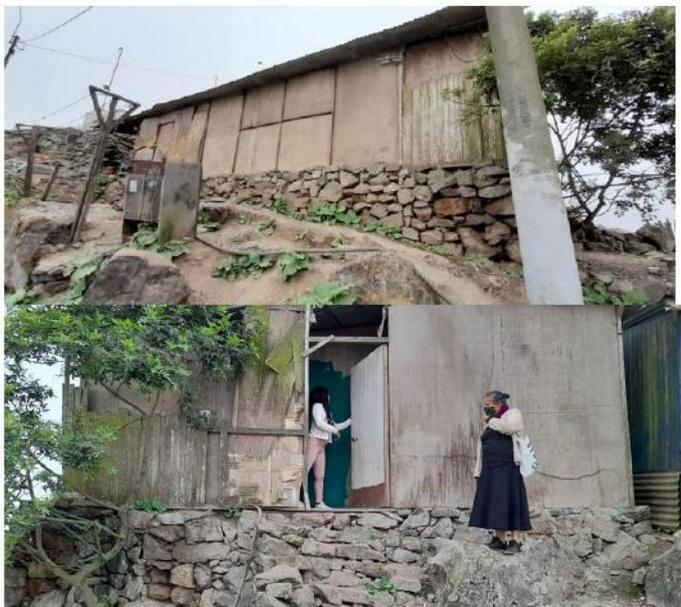
**Descripción:** Vivienda con cimentación precaria, de piedras medianas sin mortero, muros livianos sobre una losa de concreto, acceso sin tratamiento y peligroso en caso de evacuación, Ambiente múltiple, oscuro, sin iluminación ni ventilación adecuada. Estructura de techo insuficiente
