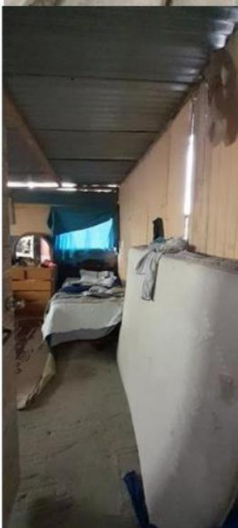
Descripción: Vivienda conformada por varias partes con estructuras mixtas. Una de albañilería confinada en primer piso con cimiento de muro de contención de concreto, el segundo piso liviano reutilizando materiales de la vivienda inicial, y acceso con base de pirca con piedras apiladas sin mortero. Muros de ladrillo muy delgado, sin compromiso estructural, lo cual sobrecarga las vigas y columnas.
