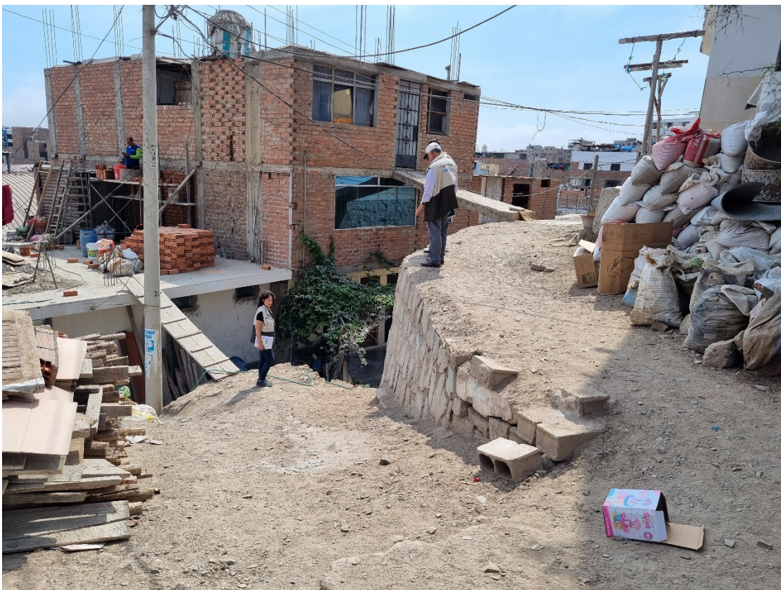
Zona de Plaza Central, pasaje de bajada hacia losa deportiva y calle Andrés A. Cáceres
