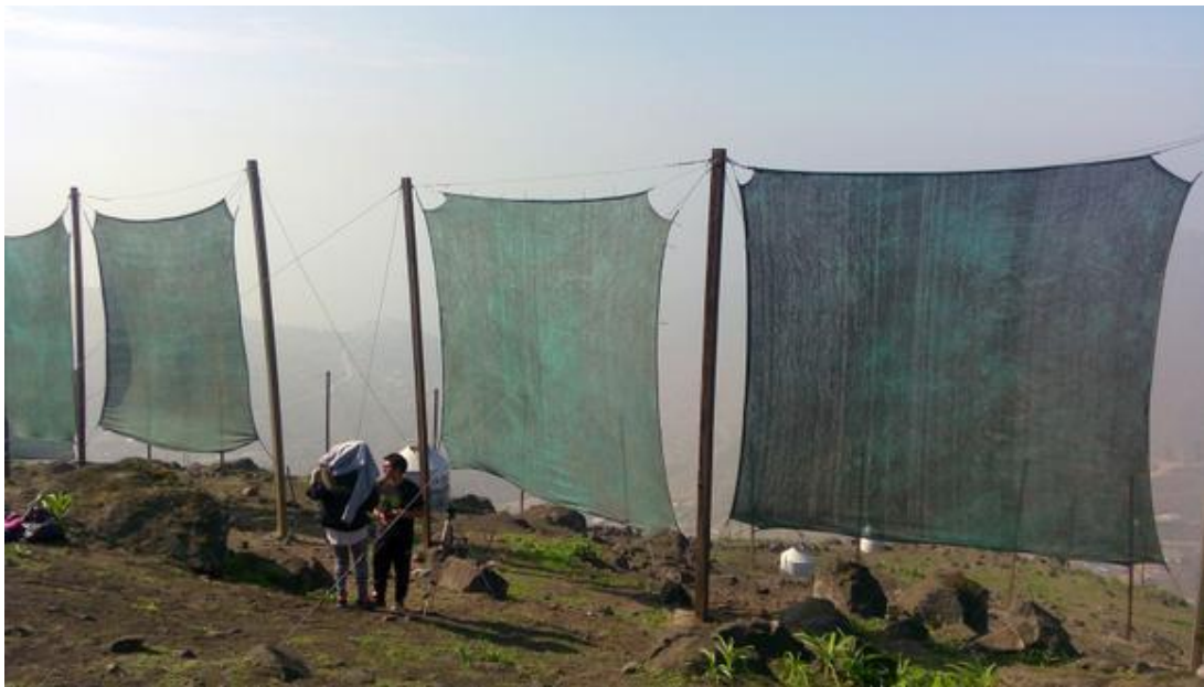
Figura 46. Atrapanieblas instalados en las lomas de Villamaría, distrito Villa María del Triunfo.
