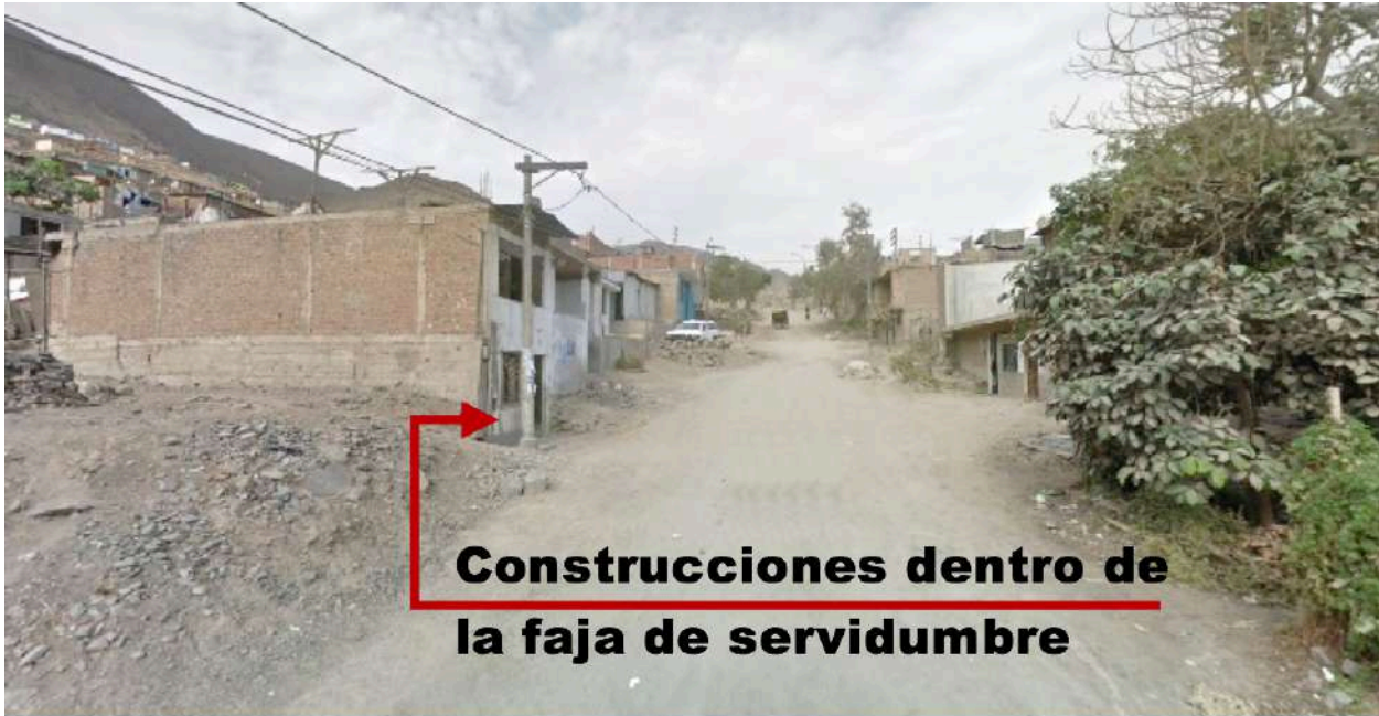
FOTO N.º 12. CALLE MICAELA BASTIDAS (A. H. VILLA FLORIDA, ZONAL 12 COLLIQUE), OCUPACIÓN DE LA FAJA DE SERVIDUMBRE ELÉCTRICA
