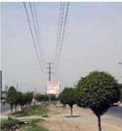
Foto N.º 9. LT CHAVARRÍA-CAUDIVILLA (L-625), DE 66 kV (AV. CHILLÓN TRAPICHE)
