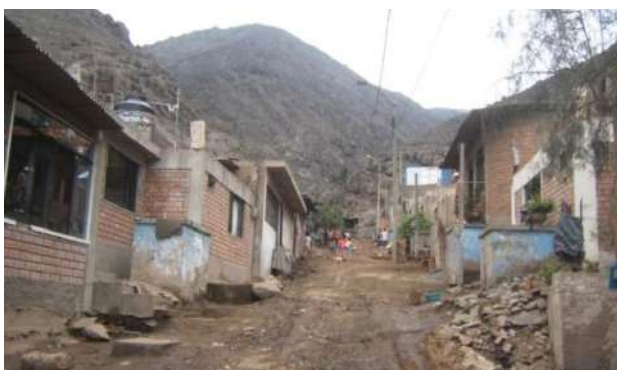
Foto N.º 43. VIVIENDAS DEL A.H. NUEVO AMANECER ASENTADAS EN EL CAUCE DE LA QUEBRADA
