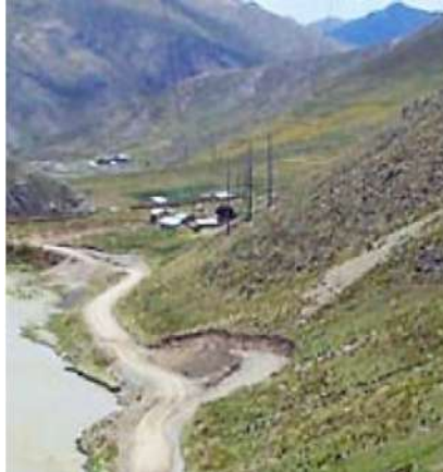
Foto N.º 7. LT CAUDIVILLA-ZAPALLAL (L-635), DE 60 kV (RÍO CHILLÓN)
