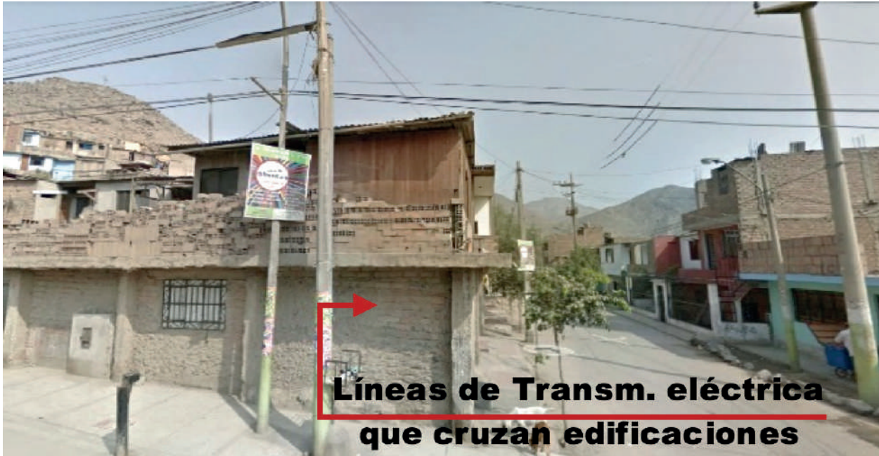
FOTO N.º 14. CALLE MICAELA BASTIDAS CON CALLE PEDRO RUIZ GALLO (A. H. COLLIQUE, ZONAL 12 COLLIQUE)
