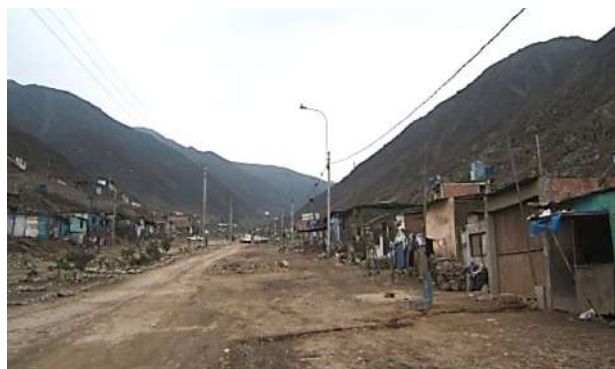
Foto N.º 40. FLUJO DE LODO SE DESPLAZA POR LA AV. REVOLUCIÓN - SECTOR SEÑOR CAUTIVO DE AYABACA (SEXTA ZONA DE COLLIQUE)
