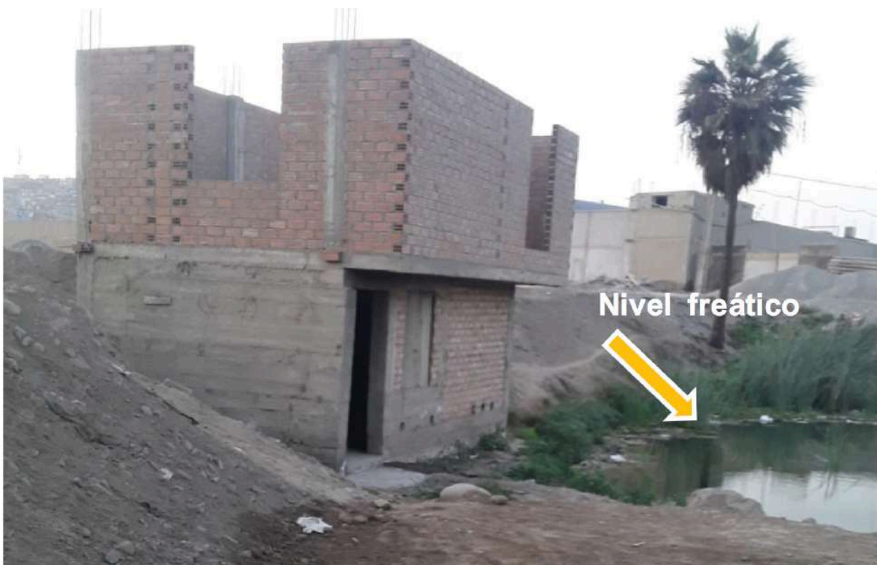
FOTO N.º 5. NIVEL FREÁTICO A NIVEL DE SUPERFICIE CALLE MARÍA PRADO DE BELLIDO N.º 21178, LOTIZACIÓN AGRARIA CHACRA CERRO, ZONAL 14 (PUNTO DE COORDENADA UTM 274,580 M E Y 8°681,981 M N)
