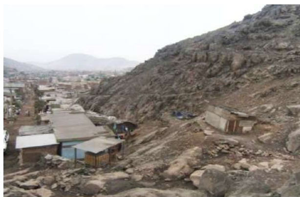
Foto N.º 38. MATERIAL SUELTO LIMO-ARENOSO, QUE FÁCILMENTE FUERON TRANSPORTADOS POR LAS LLUVIAS
