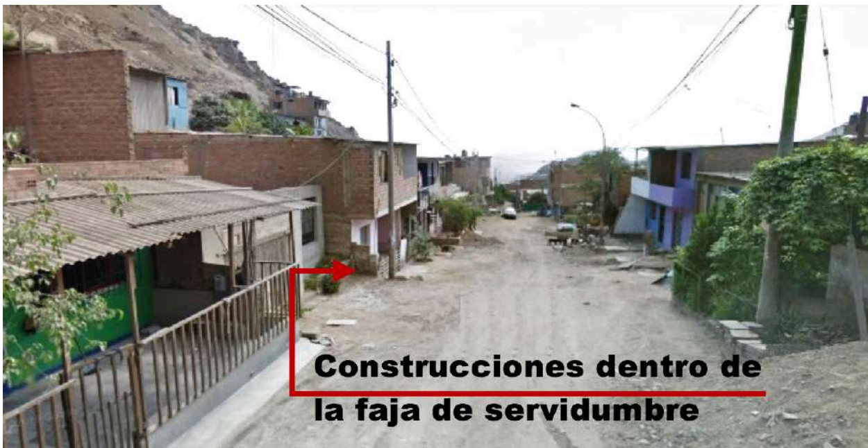
FOTO N.º 13. CALLE SAN PEDRO (A. H. VILLA COLLIQUE, ZONAL 12 COLLIQUE), OCUPACIÓN DE LA FAJA DE SERVIDUMBRE ELÉCTRICA
