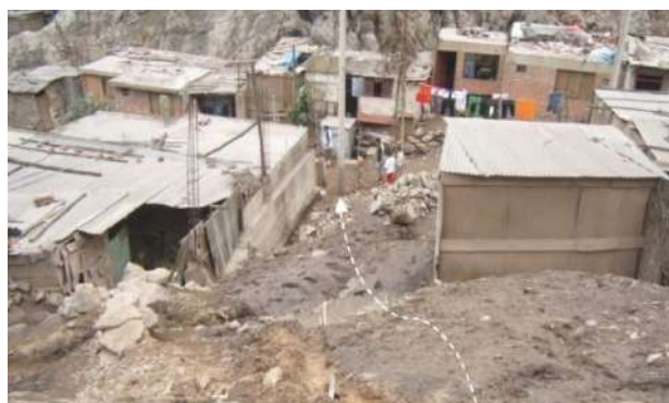
Foto N.º 44. MATERIAL SUELTO LIMO-ARENOSO, QUE FÁCILMENTE FUERON TRANSPORTADOS POR LAS LLUVIAS
