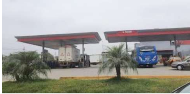
Foto N.º 21. GRIFO GAZEL SANTA CRUZ, AV. CHILLÓN TRAPICHE INTERSECCIÓN AV. LOS INCAS
