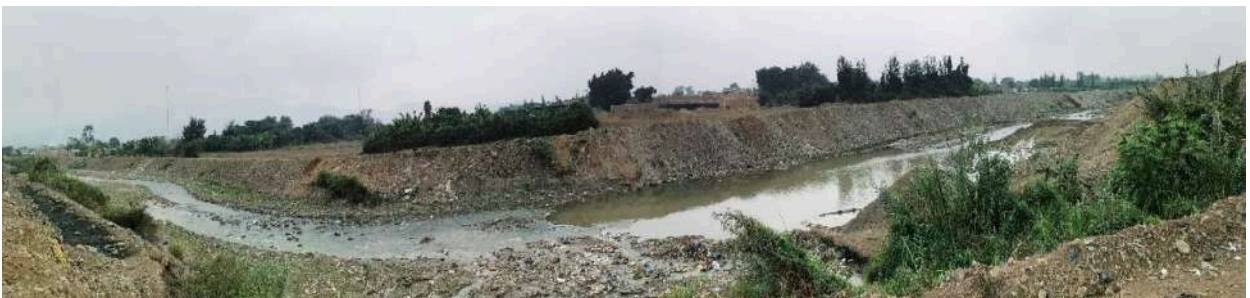
Foto N.º 36. CALLE TOMASALVA CON RÍO CHILLÓN (COLMATACIÓN DEL RÍO CON RS Y DESMONTE)
