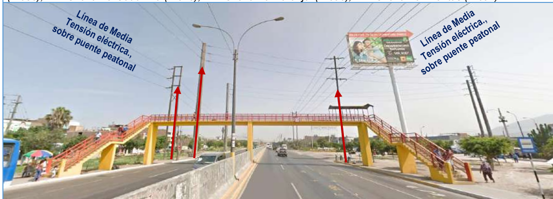
Foto N° 27: Av. Panamericana Norte, puente peatonal CASE, altura CA. Pedro Helmes, el cruce peatonal se encuentra con protección metálica, ante las líneas de Media Tensión eléctrica de 60 kv de las líneas: L.T. Chavarría-Puente Piedra (L-636), L.T. Chavarría-Caudivilla (L-625), L.T. Chavarría-Naranjal (L-698), L.T. Chavarría-Infantas (L-697).
