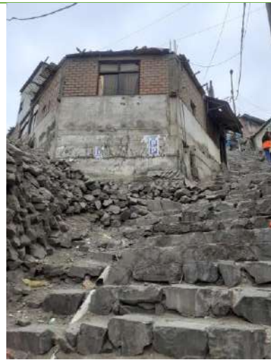
Visita de campo en el A.H. Los Angeles, inspeccionado las bases de estructuras donde están asentadas las viviendas.
