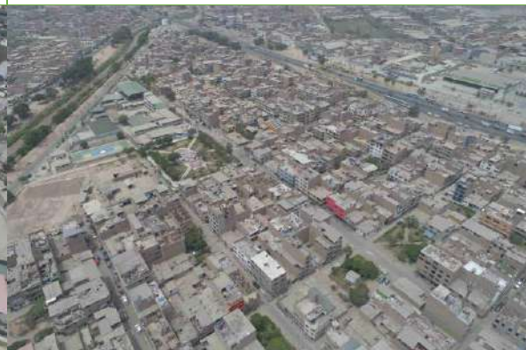
Vista aérea tomada con dron del A.H. Municipal Chillón, para el estudio de inundación fluvial de dicha zona.
