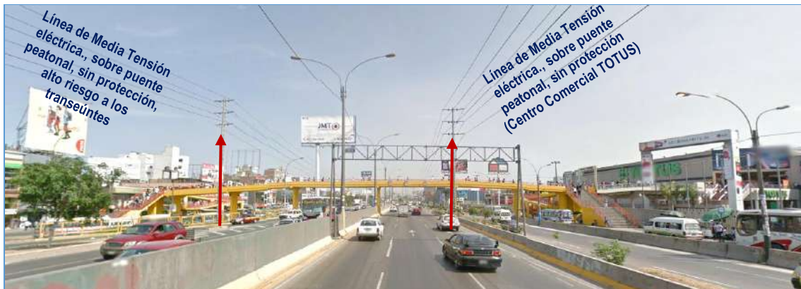
Foto N° 24: Av. Panamericana Norte, puente peatonal (MEGAPLAZA), el cruce peatonal se encuentra sin protección, ante las líneas de Media Tensión eléctrica de 60 kv de las líneas: L.T. Chavarría-Puente Piedra (L-636), L.T. Chavarría-Caudivilla (L-625), L.T. Chavarría-Naranjal (L-698), L.T. Chavarría-Infantas (L-697).
