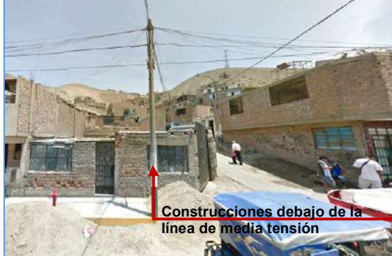
Foto N° 22: Av. Principal con Ca. Punta Arena, AH Pacífico, ocupación de faja de servidumbre eléctrica.
