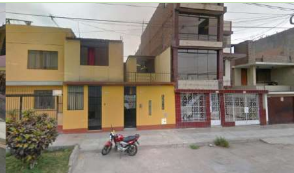
Foto N° 37: Ali Gas, se ubica en la Av. Auxiliar los Alisos con Pasaje Las Granadas.
