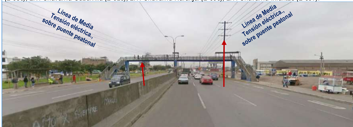
Foto N° 26: Av. Panamericana Norte, puente peatonal VIPOL, altura Jr. Chaquistambo, el cruce peatonal se encuentra con protección metálica, ante las líneas de Media Tensión eléctrica de 60 kv de las líneas: L.T. Chavarría-Puente Piedra (L-636), L.T. Chavarría-Caudivilla (L-625), L.T. Chavarría-Naranjal (L-698), L.T. Chavarría-Infantas (L-697).
