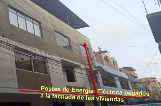
Foto N° 23: AH Los Olivos de Pro, postes de energía eléctrica, pegados a la fachada de las viviendas.
