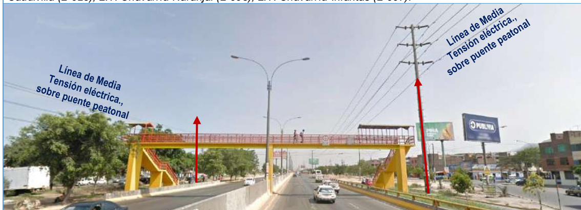
Foto N° 25: Av. Panamericana Norte, puente peatonal VOLVO, altura Jr. Las Acurinas, el cruce peatonal se encuentra con protección metálica, ante las líneas de Media Tensión eléctrica de 60 kv de las líneas: L.T. Chavarría-Puente Piedra (L-636), L.T. Chavarría-Caudivilla (L-625), L.T. Chavarría-Naranjal (L-698), L.T. Chavarría-Infantas (L-697).
