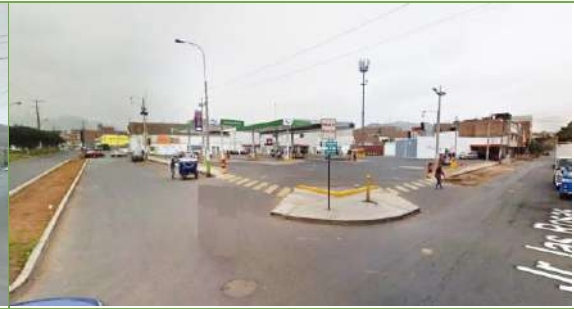
Foto N° 29: Grifo Corporación PYX SAC, se ubica en la intersección Av. Angélica Gamarra y jr. Las Rosas.
