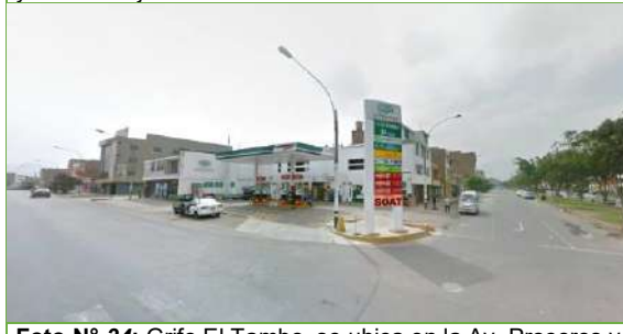
Foto N° 34: Grifo El Tambo, se ubica en la Av. Proceres y AV. Zaragoza.
