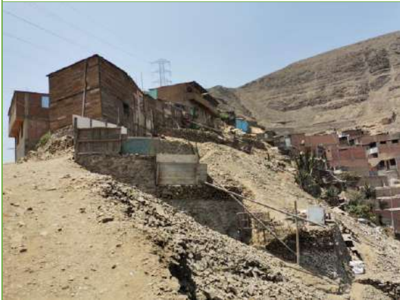
Viviendas ubicadas en pendiente alta, a lo largo del Cerro Muleria
