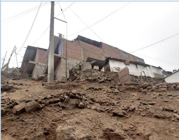
**Foto N° 1:** viviendas construidas sin seguir las normas técnicas, base inestable. Elementos expuestos: postes y cables de luz.
