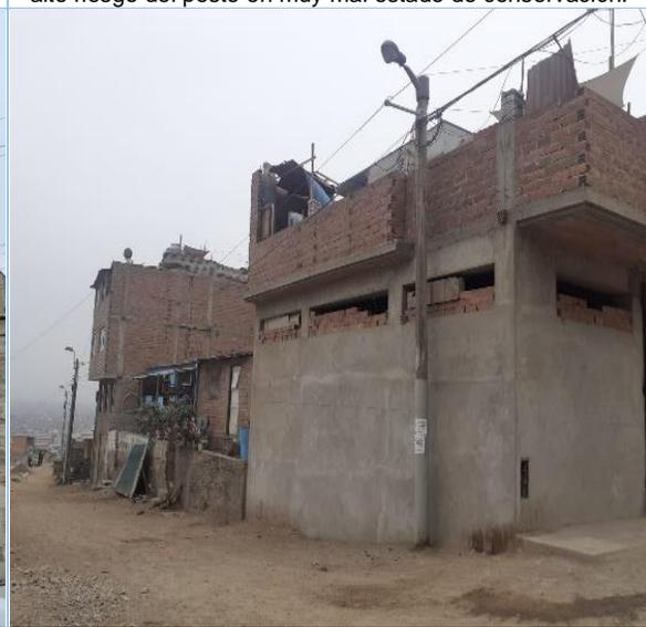
Foto N° 10: exposición de cables de luz con el segundo piso de la vivienda.
