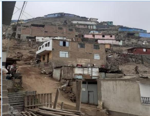
**Foto N° 2:** viviendas construidas sin seguir las normas técnicas, base inestable con llantas y rocas. Elementos expuestos: postes y cables de luz y viviendas en la parte inferior en caso de derrumbe.
