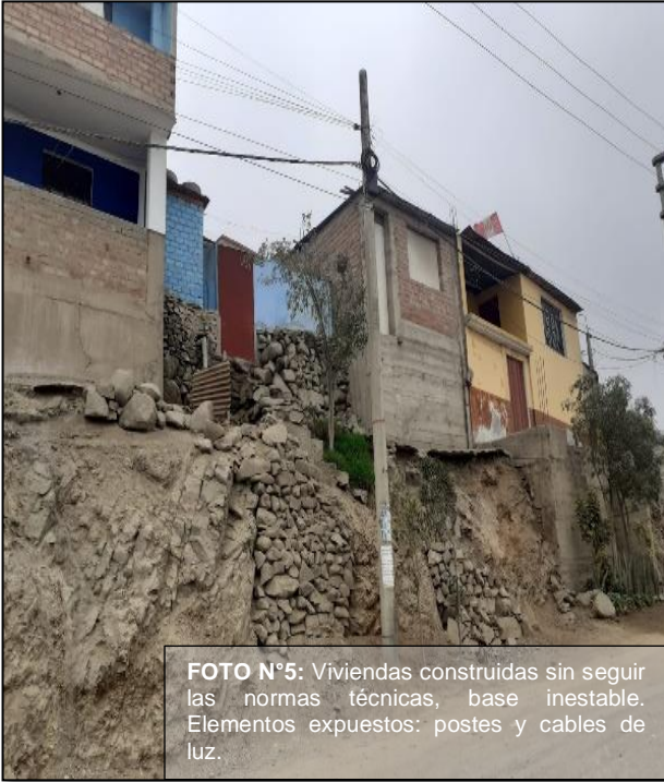
FOTO N°7: Viviendas construidas sin seguir las normas técnicas, base inestable. Elementos expuestos: postes y cables de luz.
