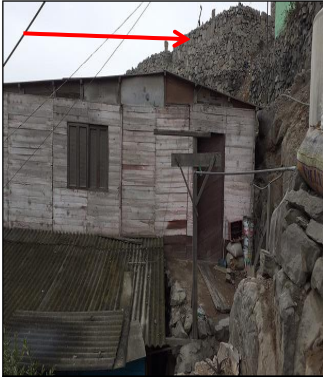
FOTO N° 5: Pircas poco compactadas puede ocasionar caída de rocas. Se necesita estabilizarlas con muros de contención.
