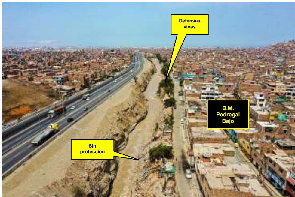
Fotografía 59 – vista de parte del tramo 2 (sentido este – oeste)
