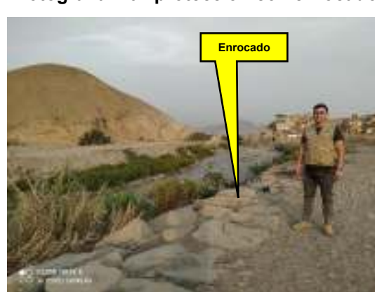
Fotografía 40– protección con enrocado
