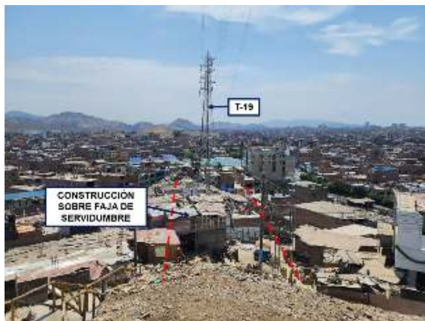
Fotografía 4 – Vivienda dentro de la faja de servidumbre visto desde la torre T-18
