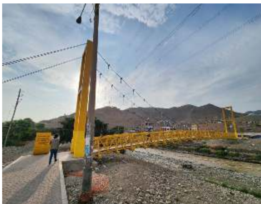
Fotografía 45 – Puente Del Sol
