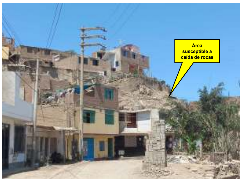
Fotografía 27 – Área susceptible a caídas de rocas
