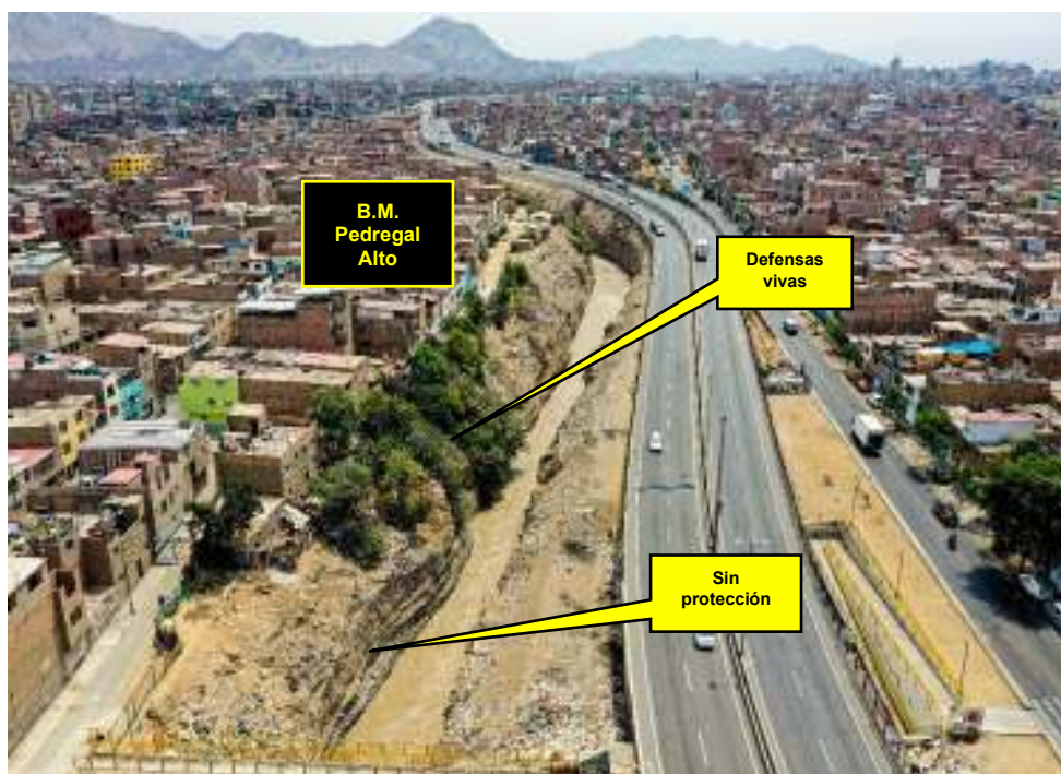
Fotografía 57 – vista de parte del tramo 2 (sentido oeste – este)
