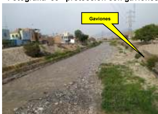
Fotografía 39– protección con gaviones
