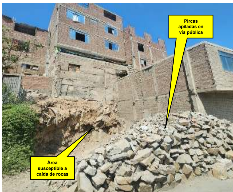
Fotografía 23 – Talud fracturado y pircas apiladas
