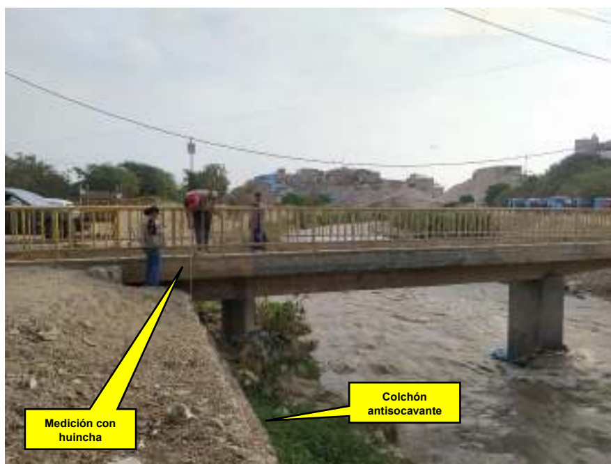
Fotografía 48 – Altura existente en punto crítico puente Nueva Esperanza
