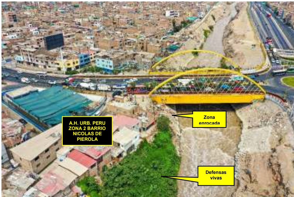
Fotografía 62 – vista de parte del tramo 4 (sentido oeste – este)
