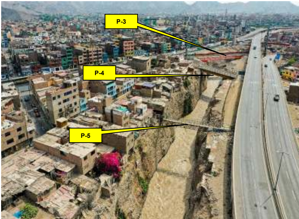
Fotografía 66 – Puente Entrada a la Línea Amarilla, Puente Santa María y Puente Peatonal 1
