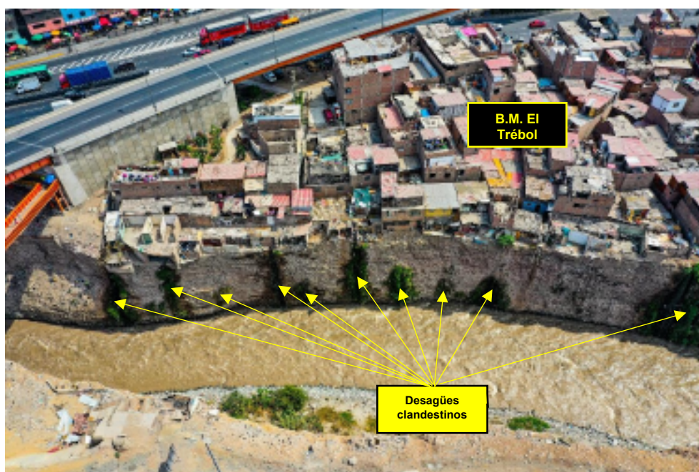
Fotografía 55 – vista de talud (B.M. El Trébol)
