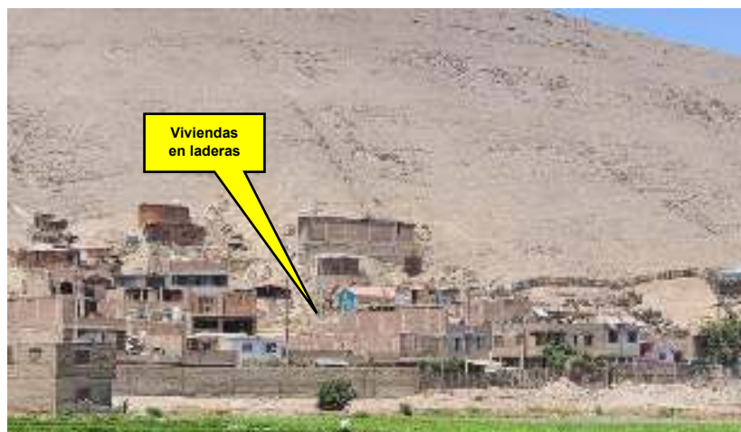
Fotografía 34 – Vista de parte del Cerro Las Ánimas
