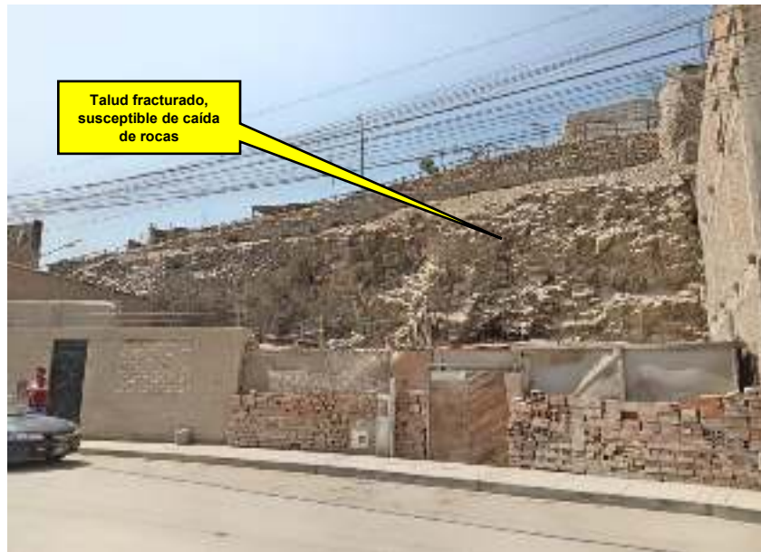
Fotografía 22 – Talud fracturado
