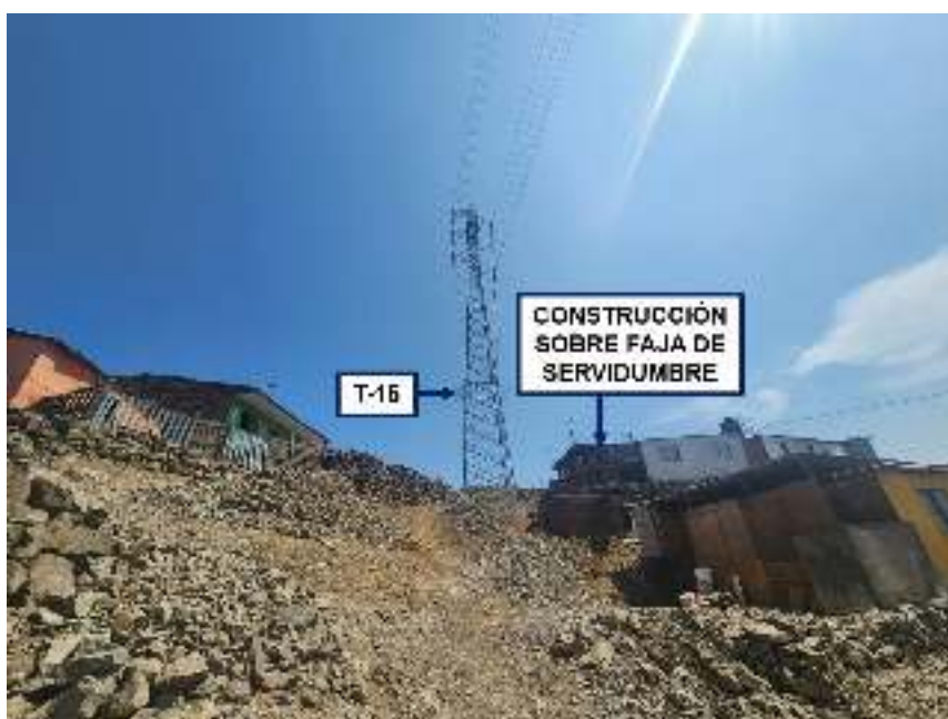
Fotografía 3 – Vivienda dentro de la faja de servidumbre de la torre T-15
