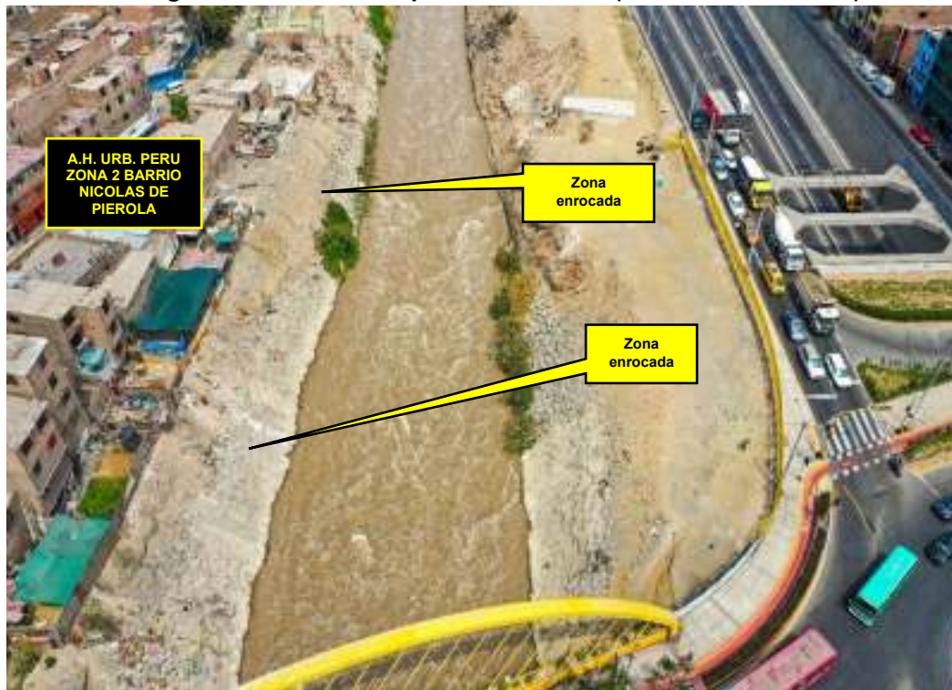
Fotografía 61 – vista de parte del tramo 3 (sentido oeste – este)
