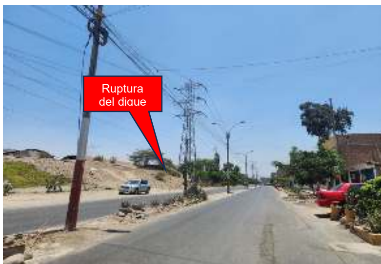
Fotografía 1 – ruptura del dique que dio inicio a la inundación
