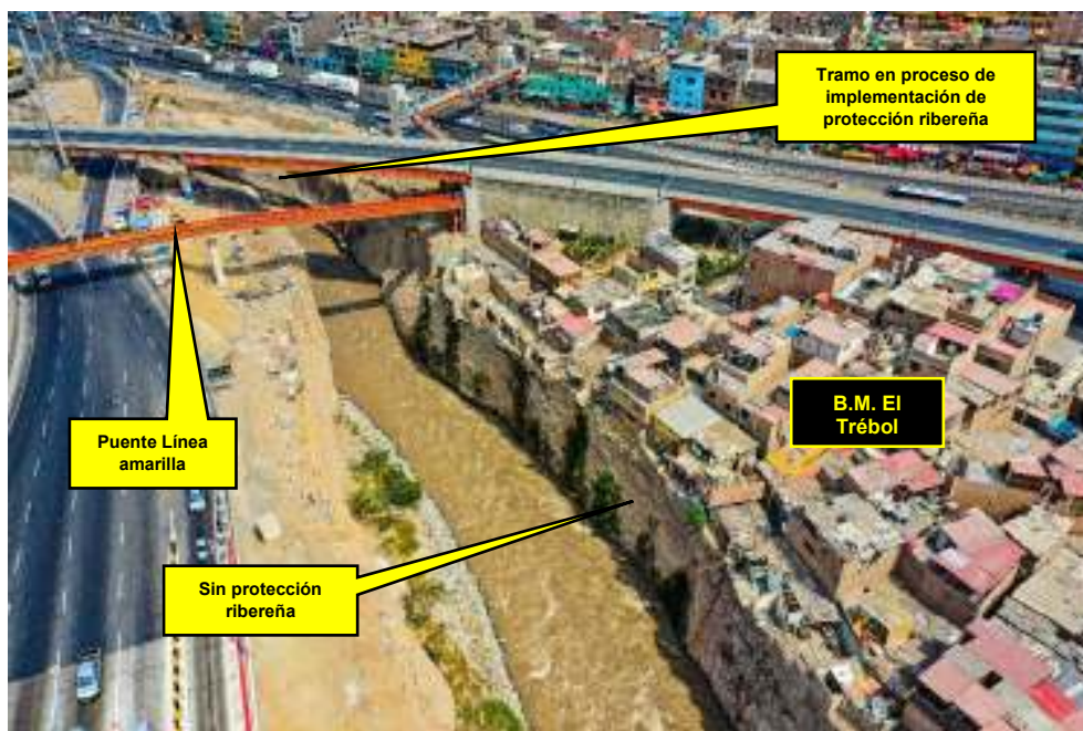
Fotografía 54 – vista de parte del tramo 1 (sentido este – oeste)
