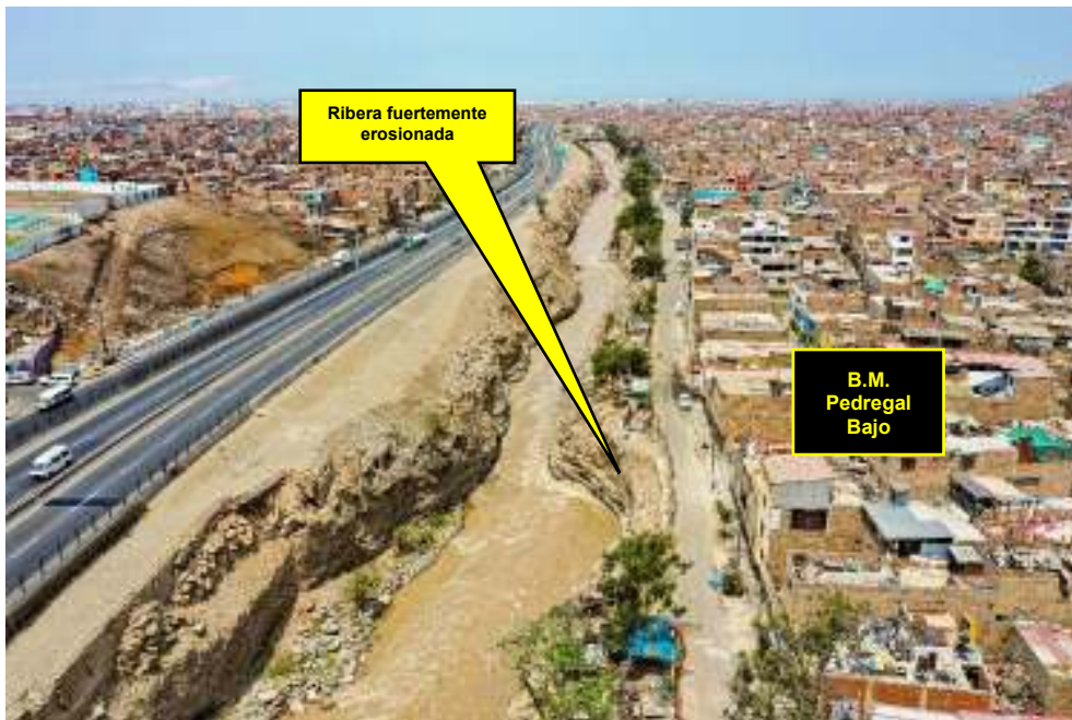
Fotografía 58 – vista de parte del tramo 2 (sentido este – oeste)
