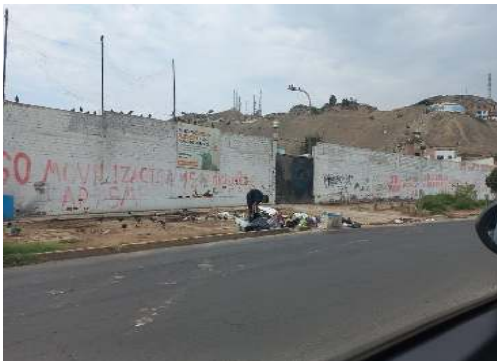
Fotografía 15 – Punto crítico de residuos sólido con presencia de vectores (aves) al costado de la I.E. Negreiros Vega
