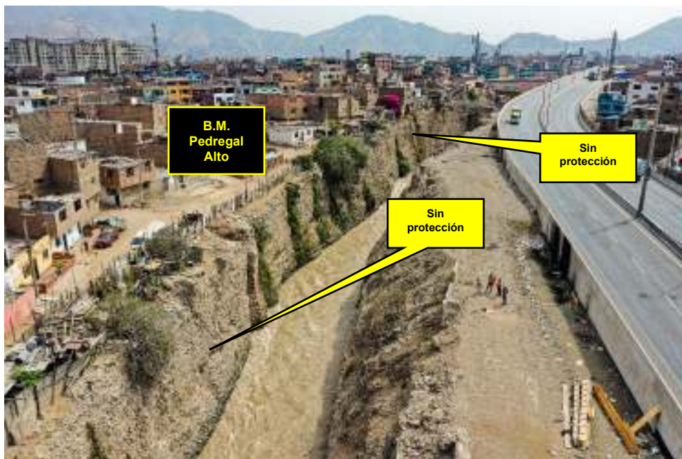
Fotografía 56 – vista de parte del tramo 2 (sentido oeste – este)
