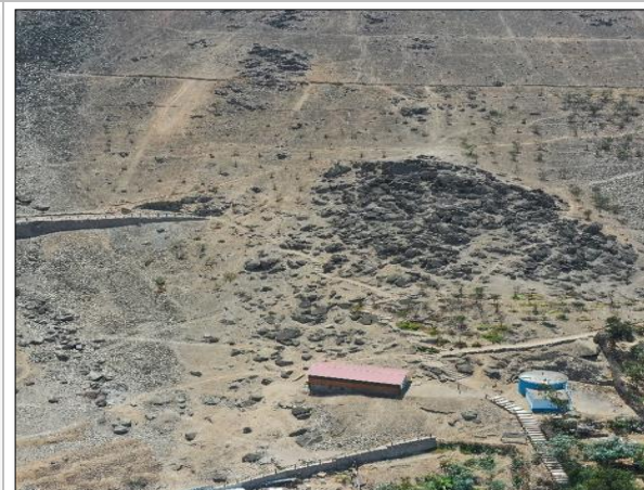
En esta vista se aprecia la parte Este del Asentamiento Humano El Volante III Etapa, donde se requiere continuar con la siembra de árboles o plantas adecuadas, para la estabilización de laderas, banquetas de estabilización, muros gaviones, para evitar la caída de rocas sobre las edificaciones e infraestructura vial.
