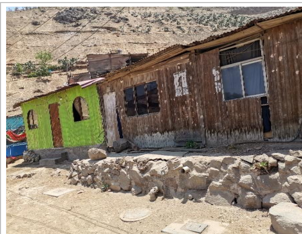
En esta vista, el predio requiere la asistencia técnica para el reforzamiento de una zona segura para movimientos sísmicos y caída de rocas.
