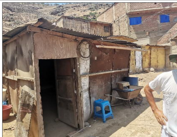
En esta vista el predio requiere de la estabilización de taludes y limpieza de escombros y el reforzamiento de una zona segura para movimientos sísmicos y caídas de rocas.
