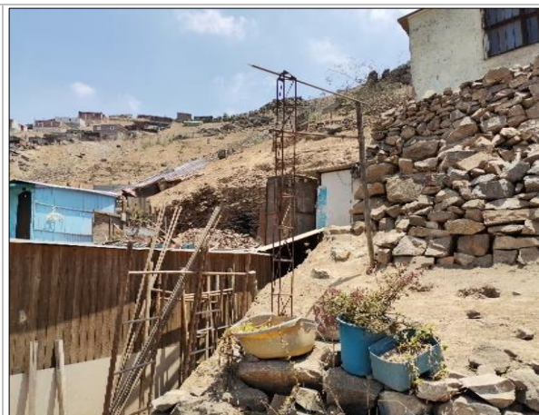
En esta vista, el predio requiere el enmallado del muro de contención, y reforzamiento de una zona segura
